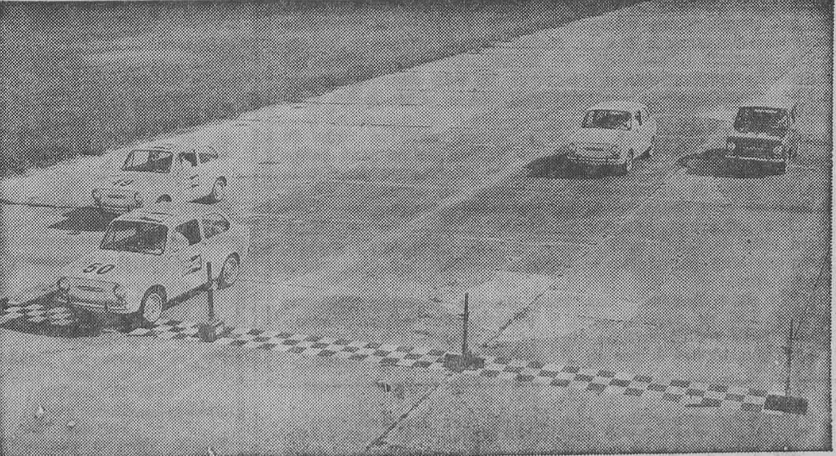
En la prueba de aceleración de 500 m., los dos Fiat-850 que van detrás, están equipados con bujías convencionales, mientras que, los que van delante, llevan bujías Champion Turbo-Action.
