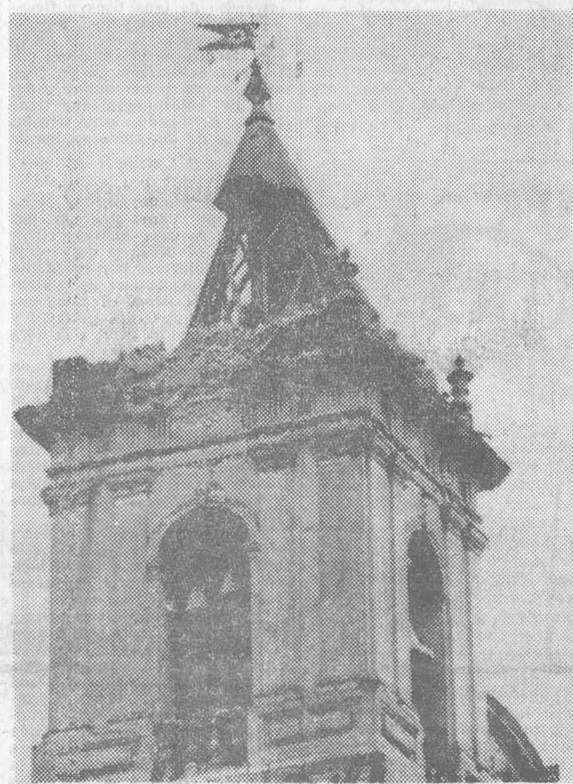
Chinquiquira (Colombia). — Los temblores de tierra registrados en una vasta extensión de Colombia y Venezuela ocasionó daños importantes en los edificios de esta localidad, como los que se pueden apreciar en la torre de la iglesia, de la que se desprendieron grandes bloques de piedra. En Colombia se registraron ocho muertos y más de cien heridos a causa del terremoto. — (Telefoto Cifra)
