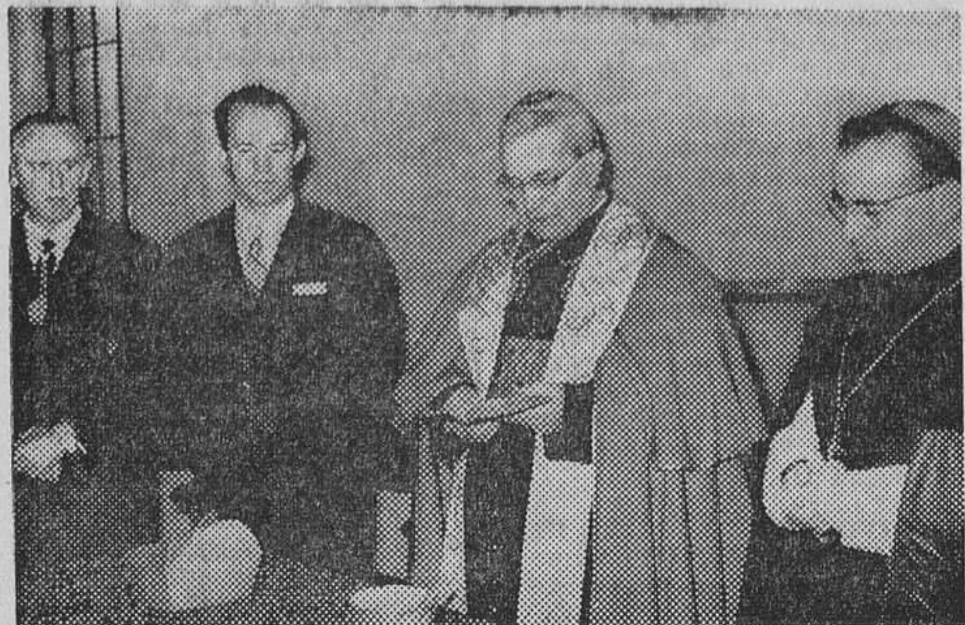
En la abadía de Poblet se ha procedido a la inauguración de las obras de reconstrucción del palacio del Rey Martí, obra llevada a cabo por el servicio de Defensa del Patrimonio Artístico Nacional. En esta nota gráfica vemos al cardenal arzobispo de Tarragona, monseñor Benjamín de Arriba y Castro, en el momento de efectuar la bendición de las obras inauguradas. Junto al ilustre príncipe de la Iglesia se hallan el director general de Bellas Artes, don Gratiniano Nieto, y el abad de aquel cenobio cisterciense, Dom Edmundo María Garreta. — (Foto Cifra.)
