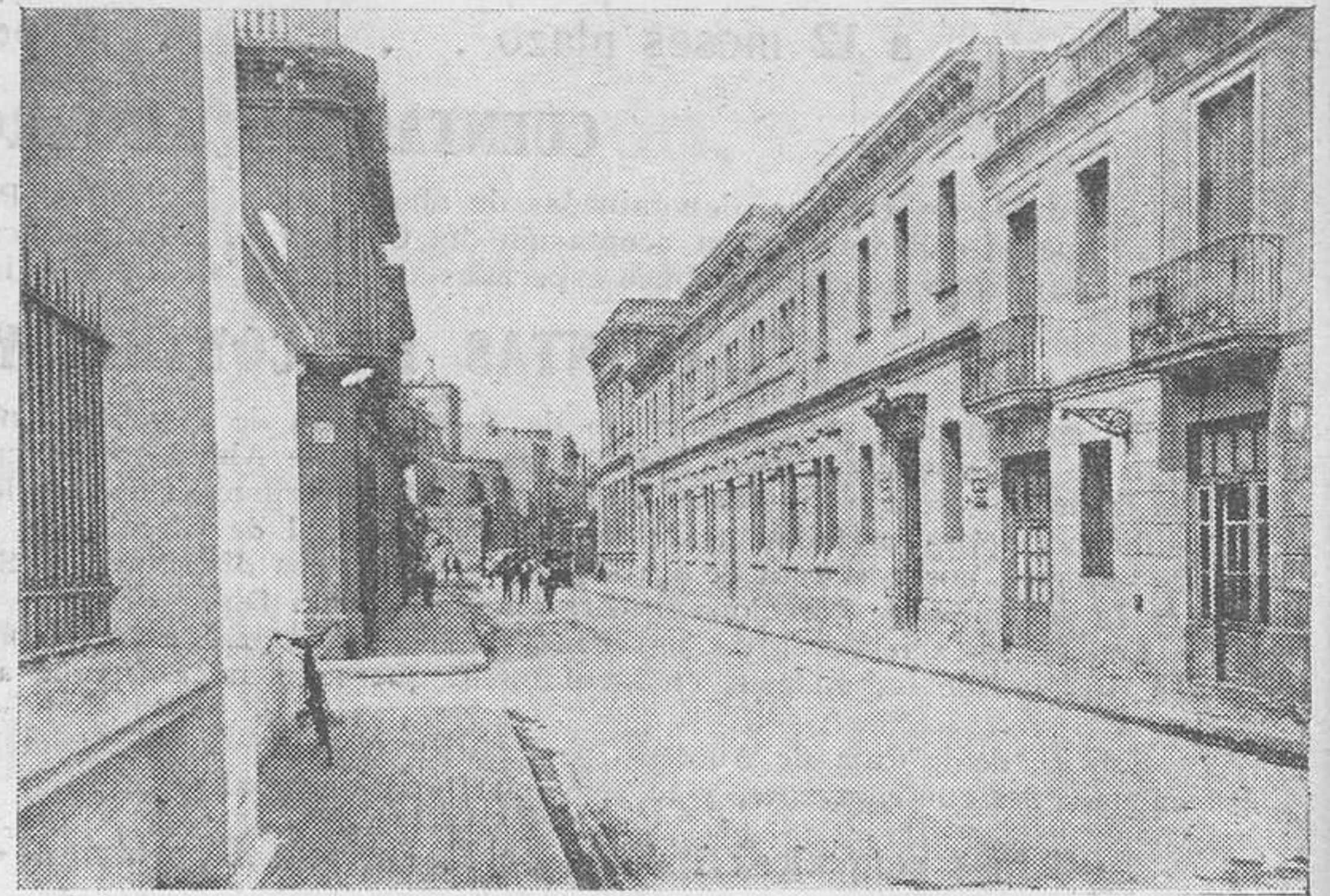
Hormigón blindado de la calle de Rosendo Arús
