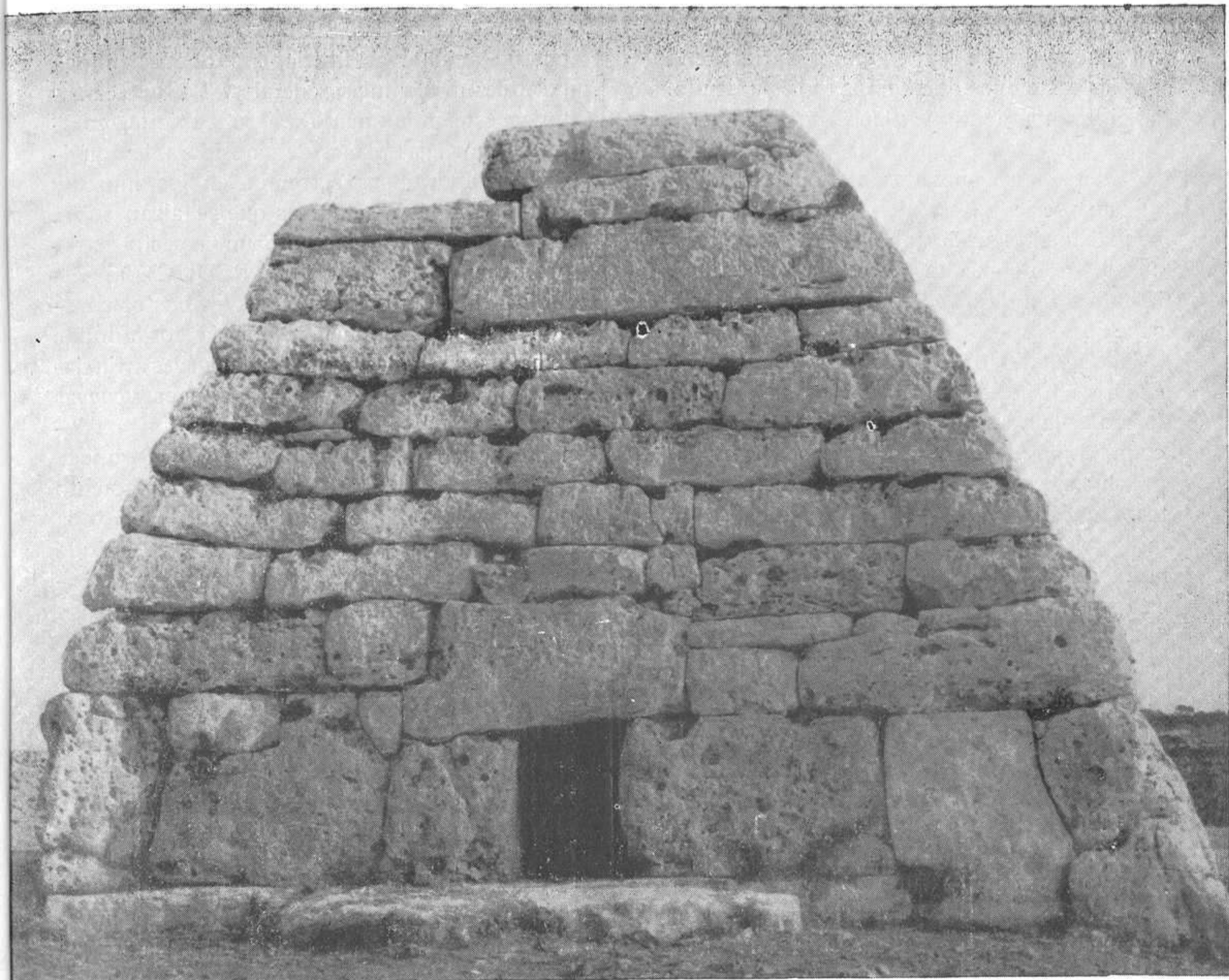
Naveta des Tudons, fachada occidental
