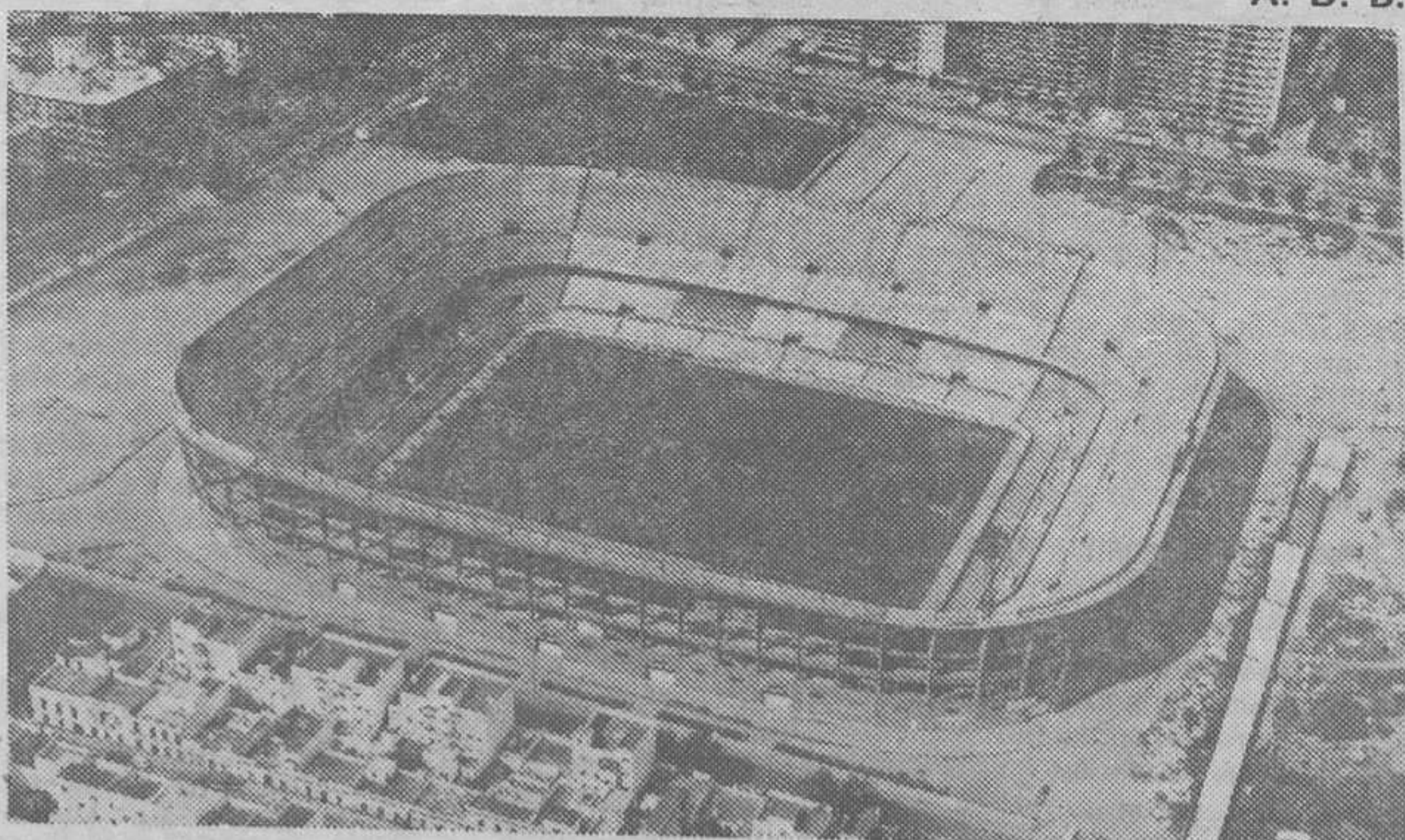
El Sánchez Pizjuán, de Sevilla, en el que hay que realizar importantes obras
