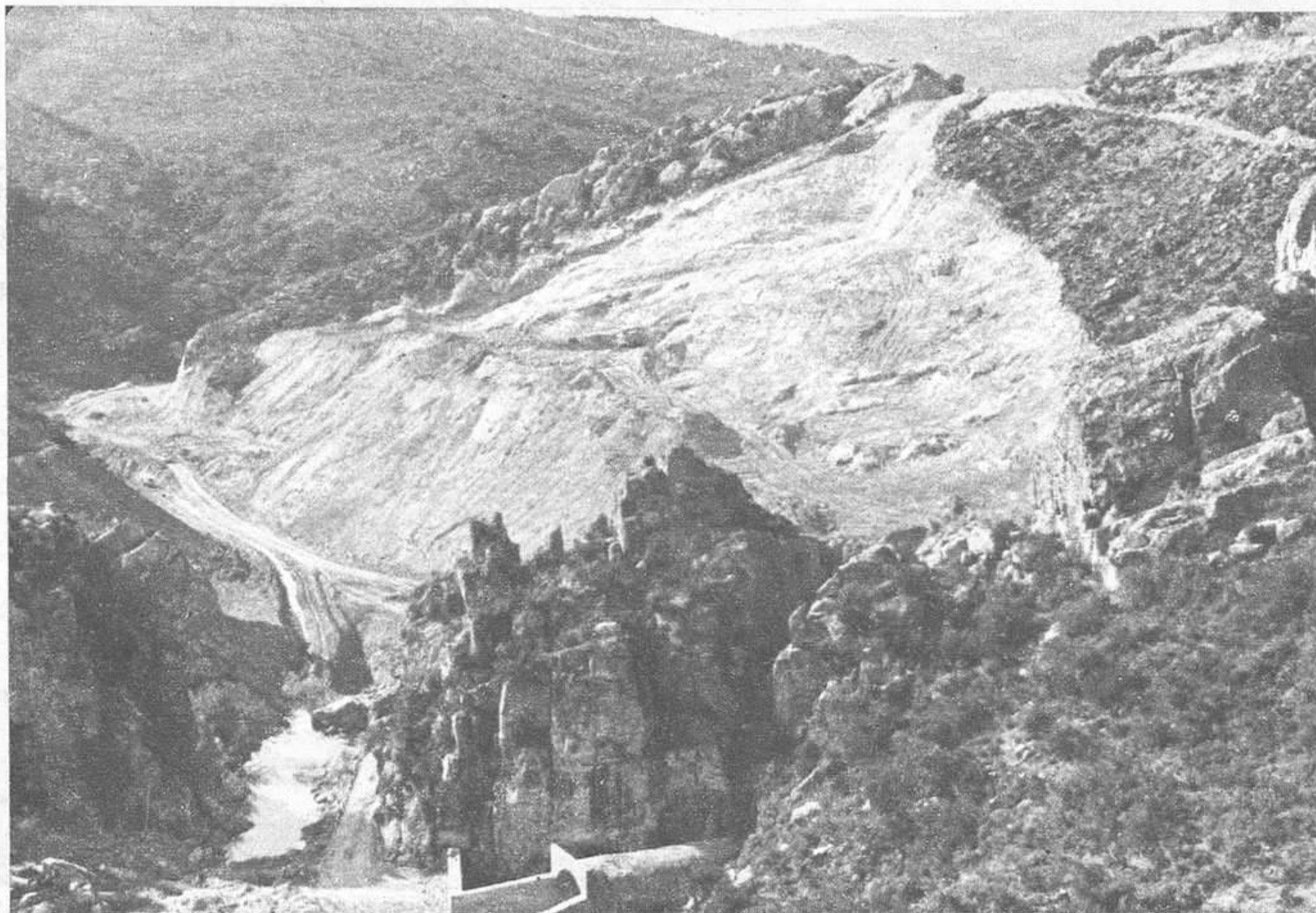
Presa de embalse Charco Redondo-río Palmones, en ejecución. Volumen de excavación y terraplén: 2.100.000 m 3 ; altura de presa: 66 m. LOS BARRIOS - CADIZ
