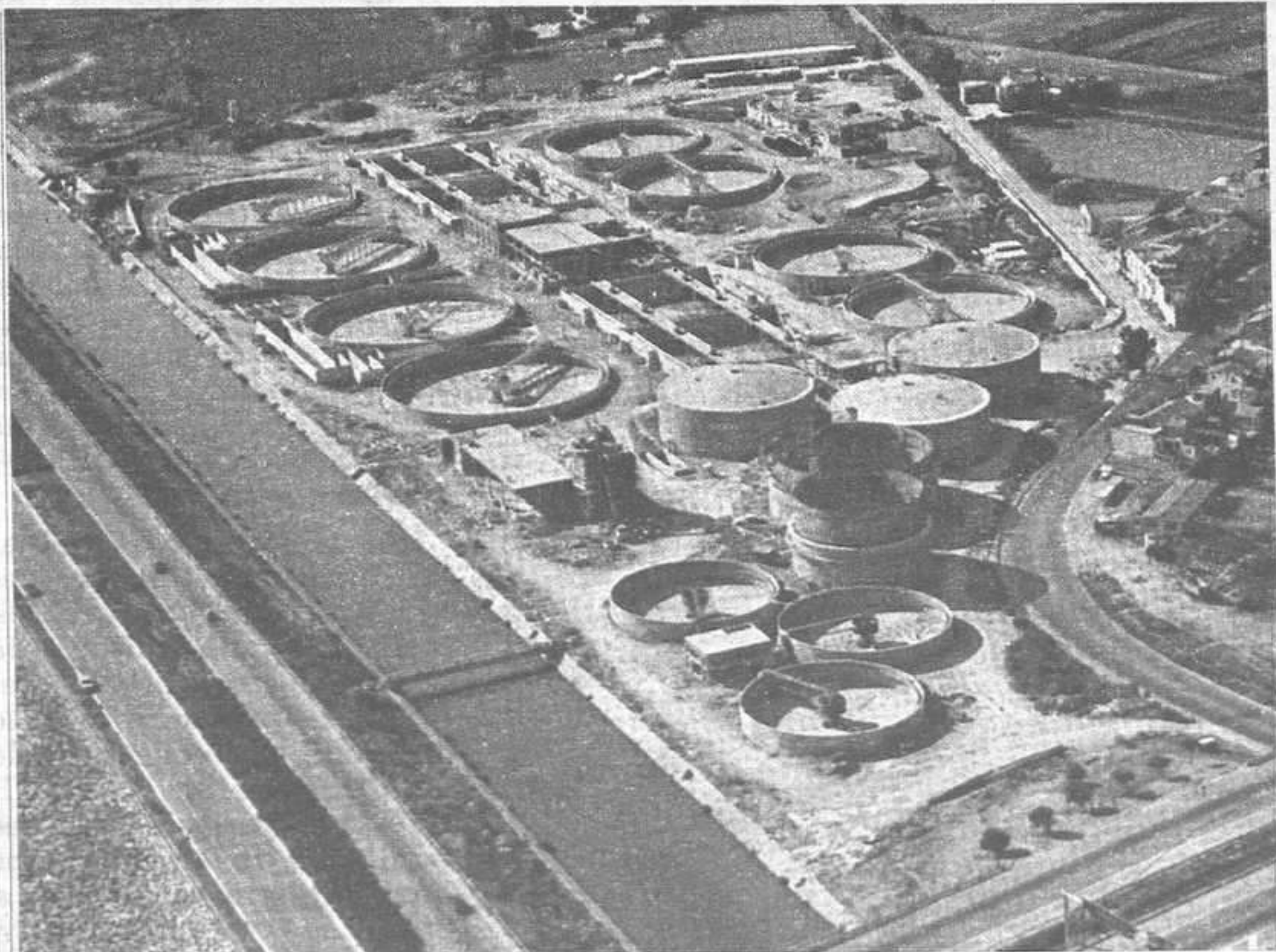
Planta de tratamiento de aguas potables de EL ATAZAR. Madrid. Capacidad: 691.200 m 3 /día.
