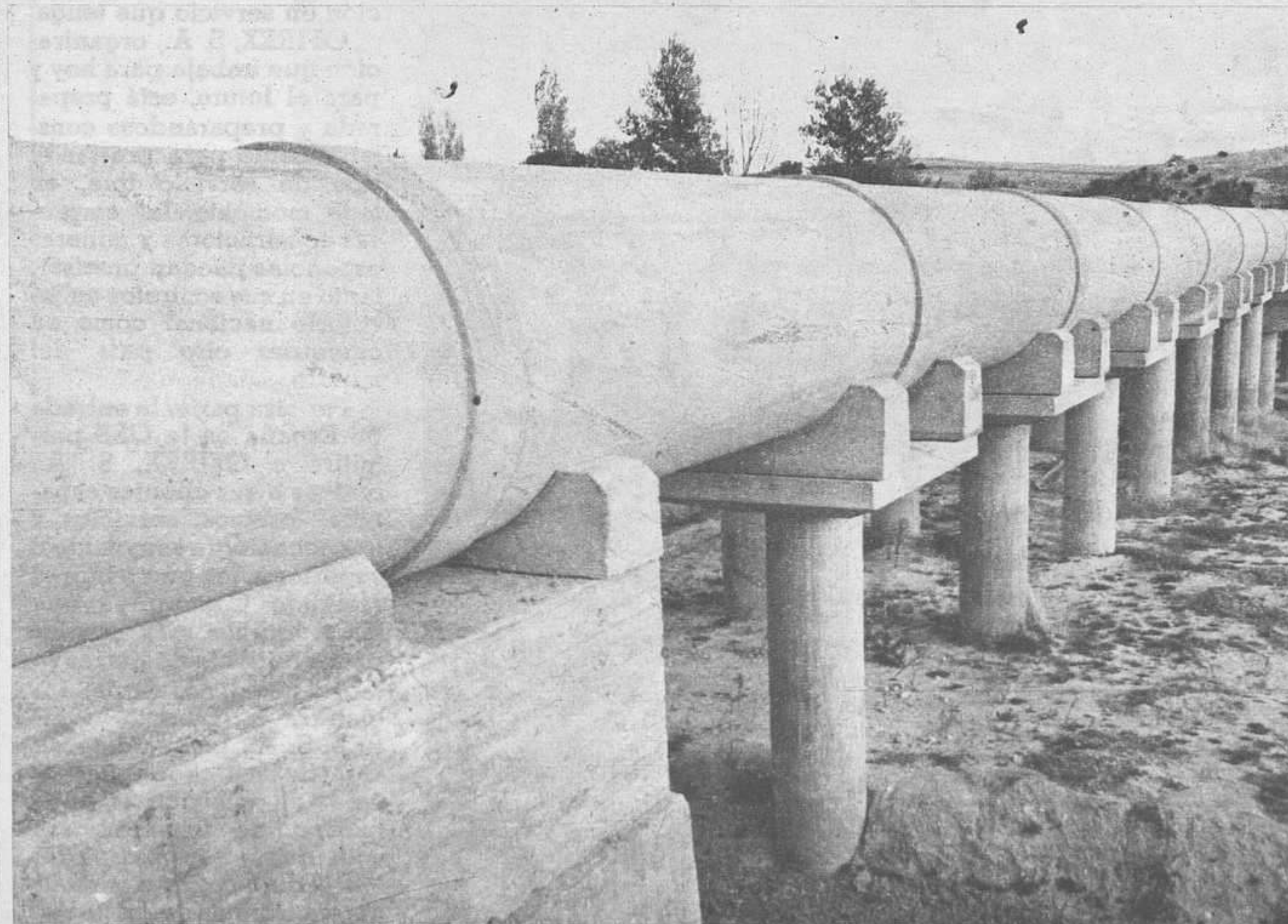
ACUEDUCTO DE «EL PLANTIO»-CONDUCCION VALMAYOR MAJADAHONDA
