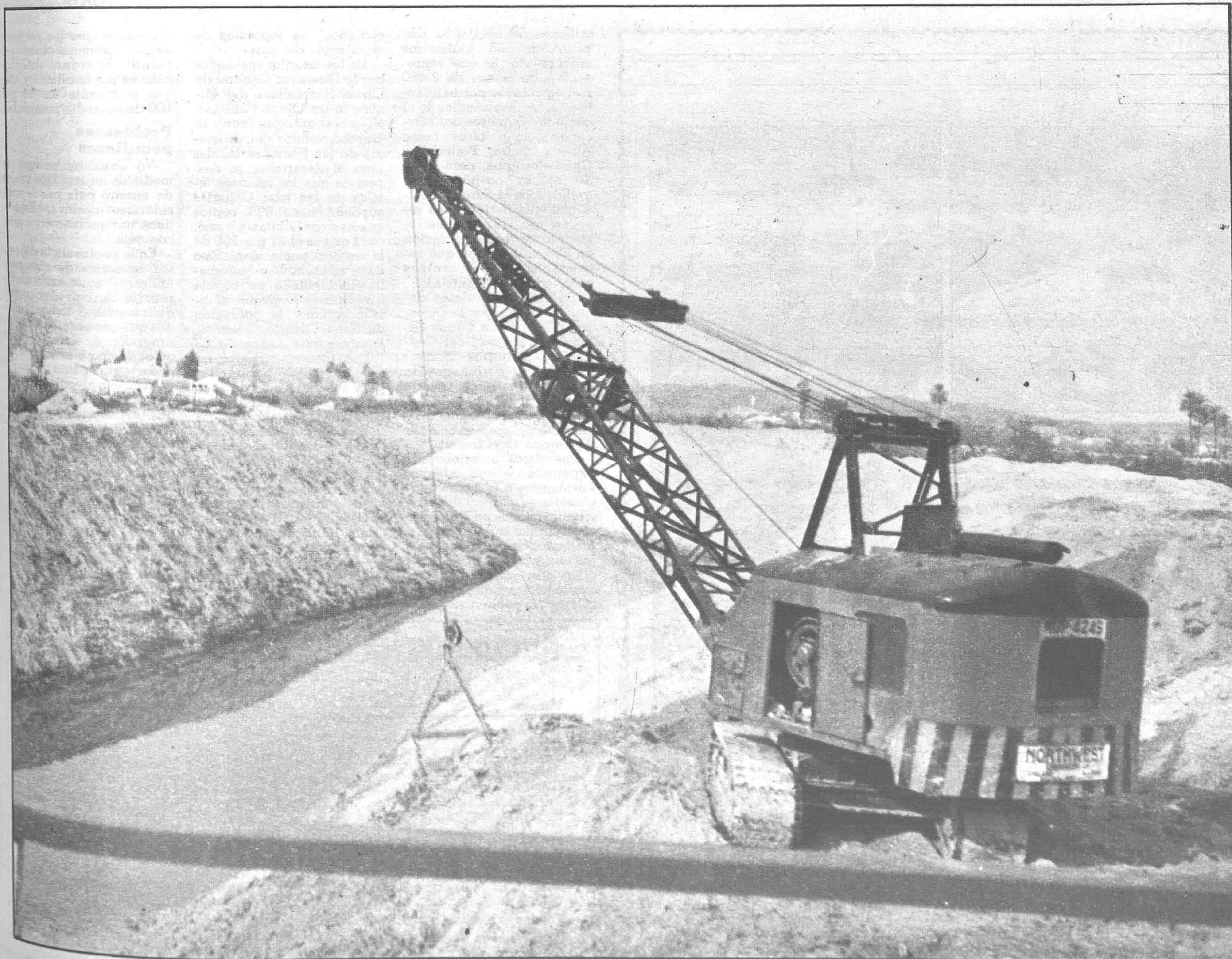
Trabajos de dragado del cauce del río Segura
