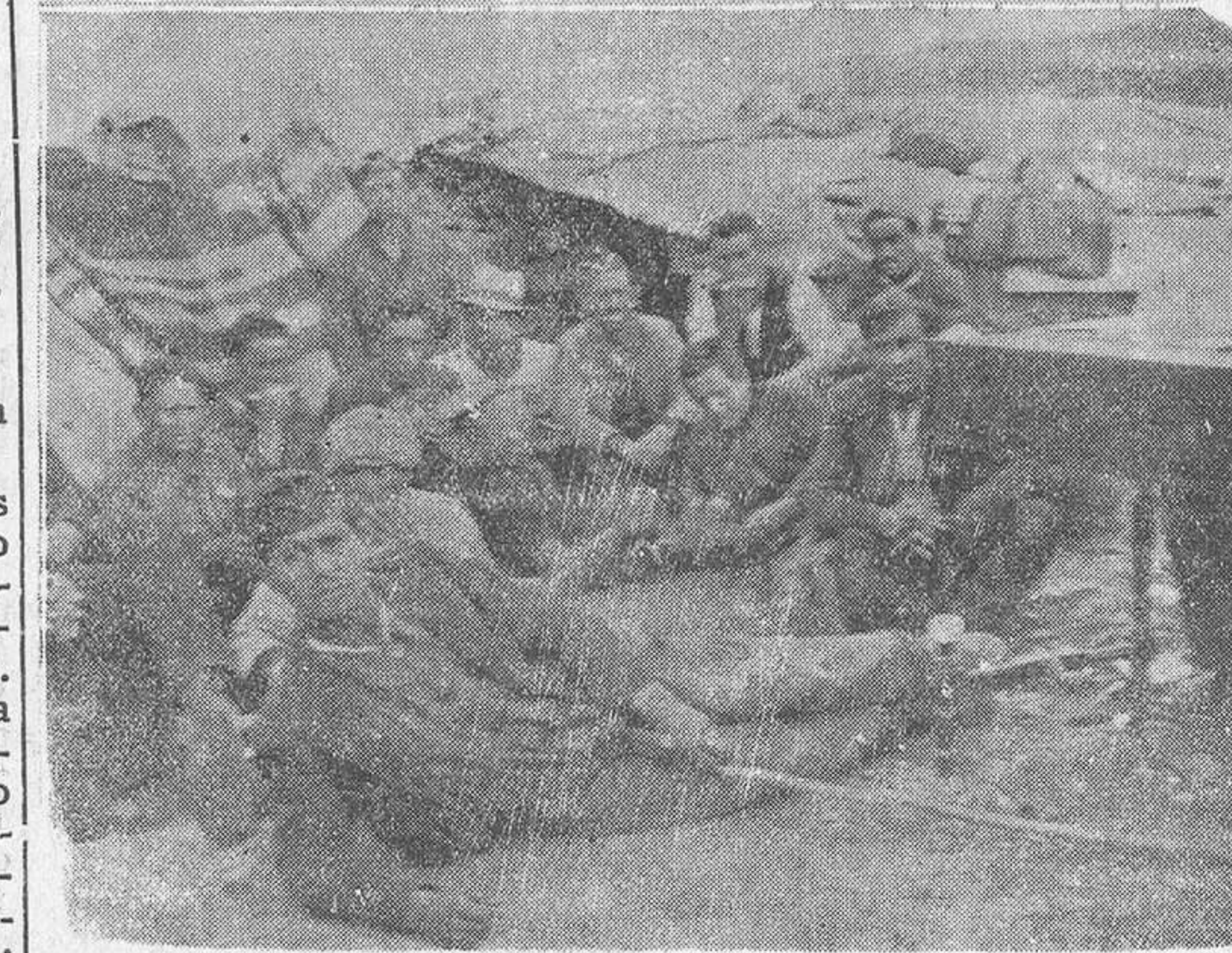
A la sombra de los parapetos en los momentos de las confidencias
