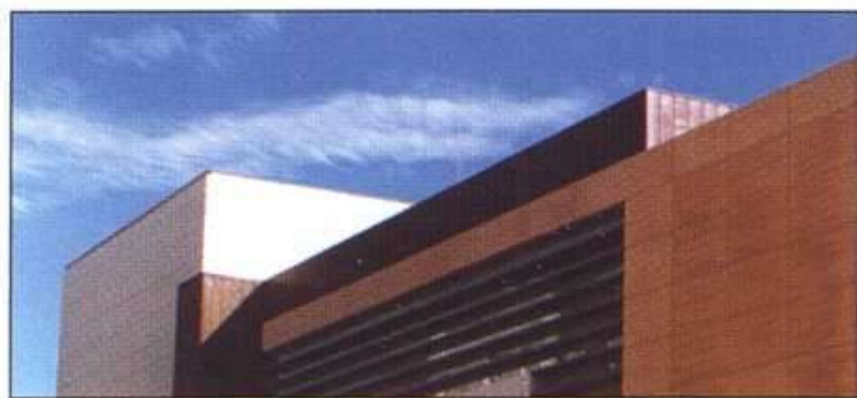
Imagen del Auditorio de Aldaia.
