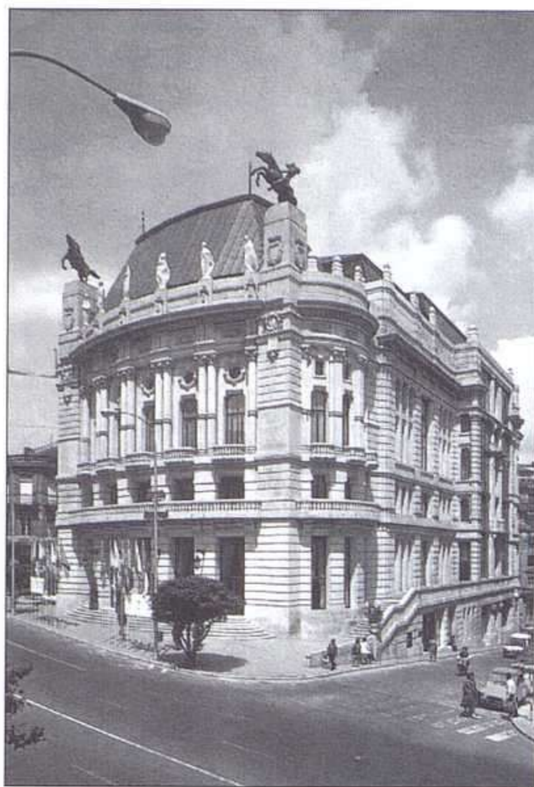
Vista del Edificio del Centro "Caixavigo"
