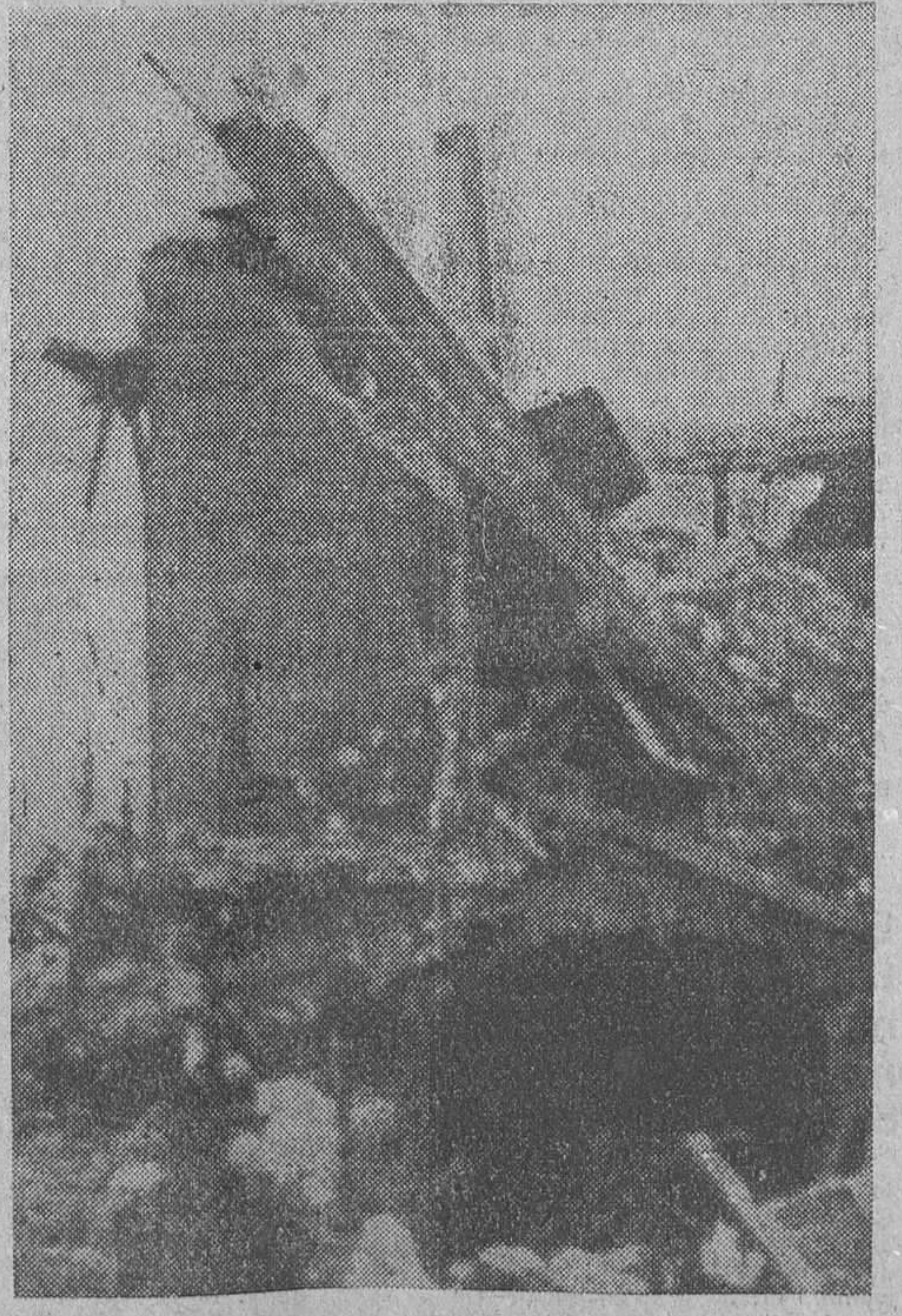
RUINAS.—El paso de las fuerzas fascistas deja en todos los pueblos la huella de su barbarie sin límites. Antes de abandonar sus posiciones, obligados por el empuje de nuestras milicias, reducen a escombros las humildes casas donde se hacían fuertes. He aquí una impresionante instantánea obtenida a la entrada de nuestras tropas en uno de los últimos pueblos reconquistados (Fot. D. Casariego.)
