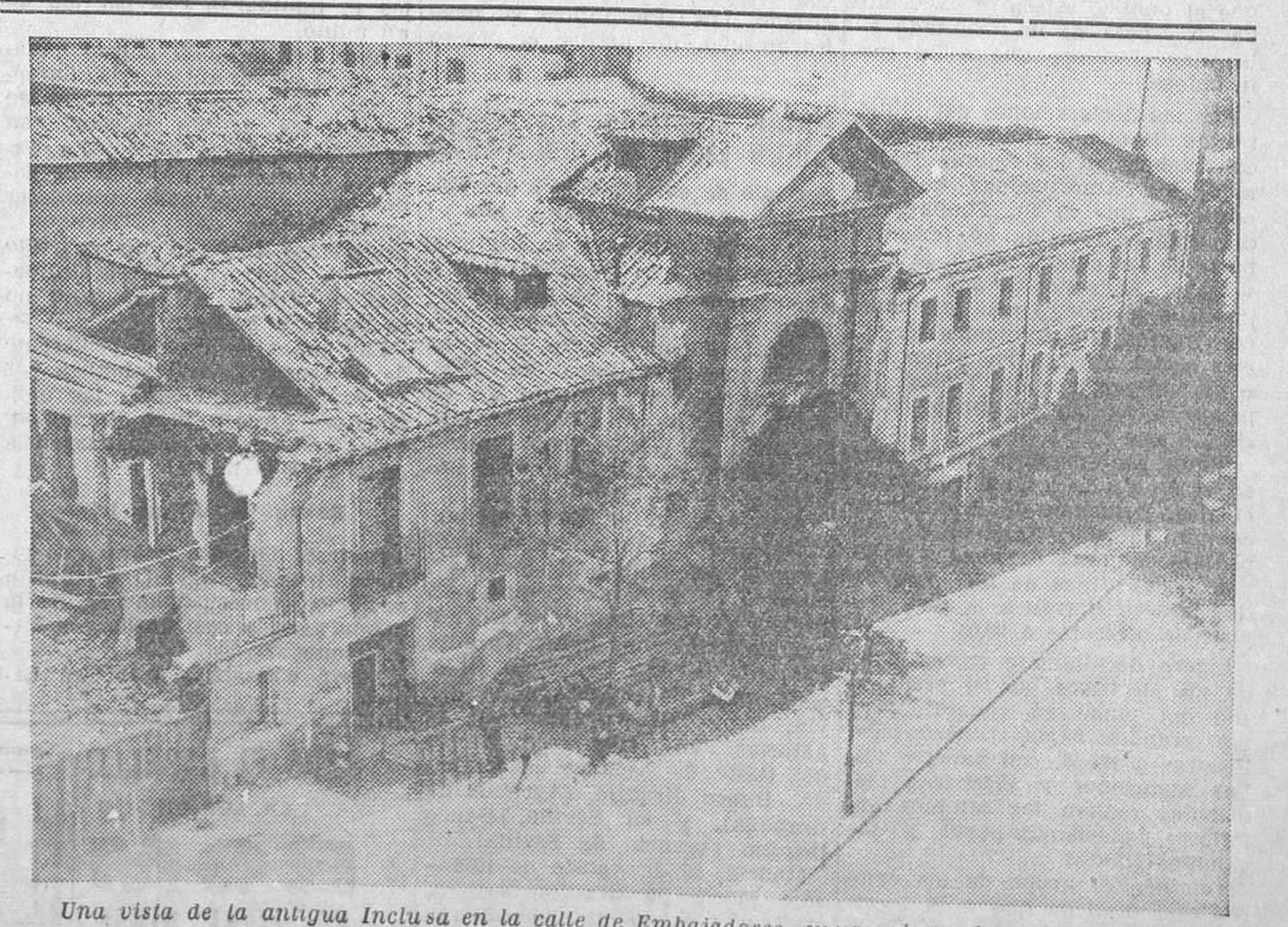
Una vista de la antigua Inclusa en la calle de Embajadores, cuyas obras de demolición han comenzado (Fot. Alfonso.)
