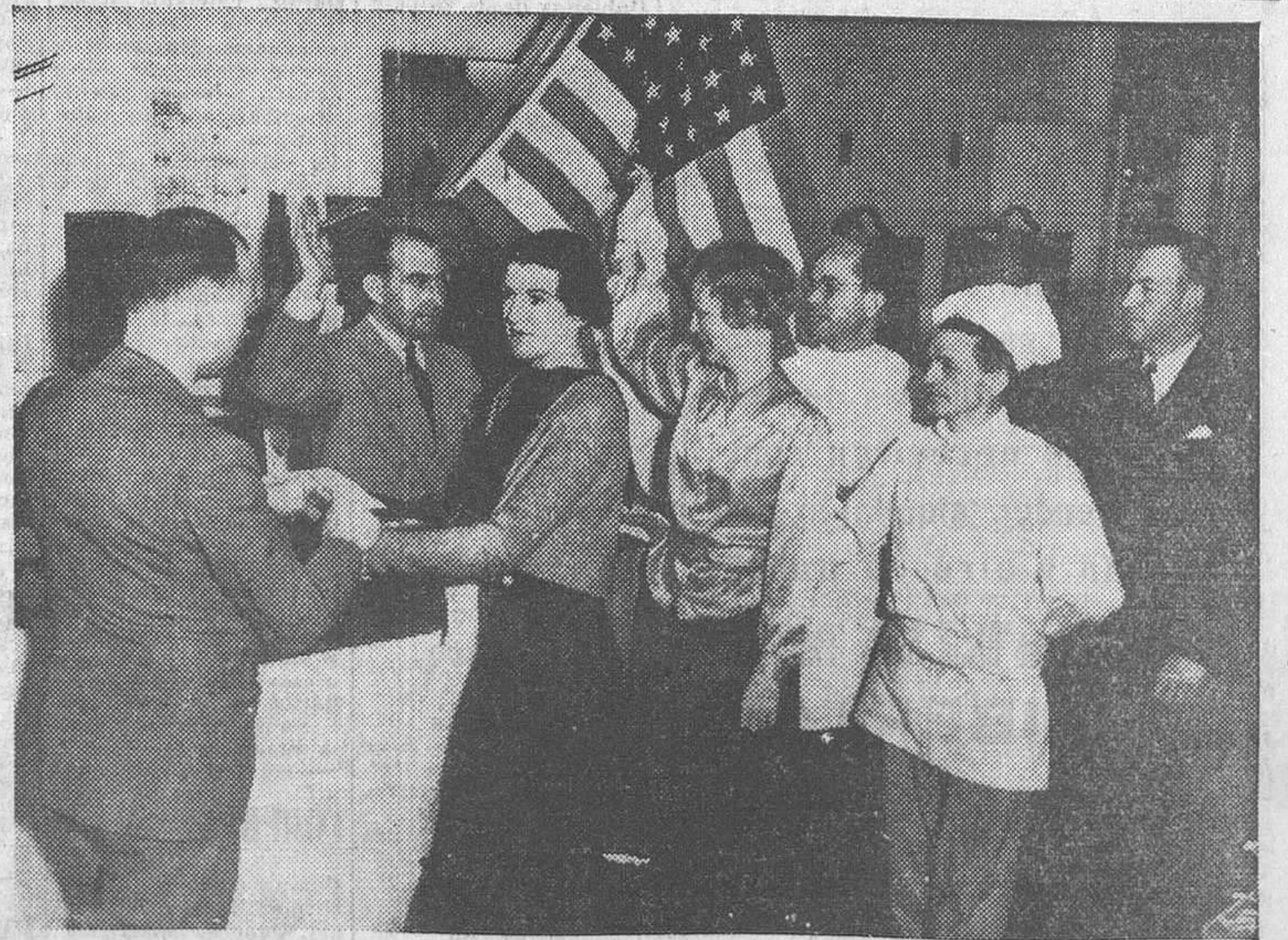
En los hoteles de Los Angeles (Estados Unidos) se vienen realizando robos con demasiada frecuencia. La Policía y los propietarios de los hoteles toman toda clase de precauciones que den las máximas garantías a los clientes. En la foto vemos a la dependencia de un hotel de Los Angeles en la operación de marcar sus huellas dactilares (Fot. Ortiz-Keystone.)
