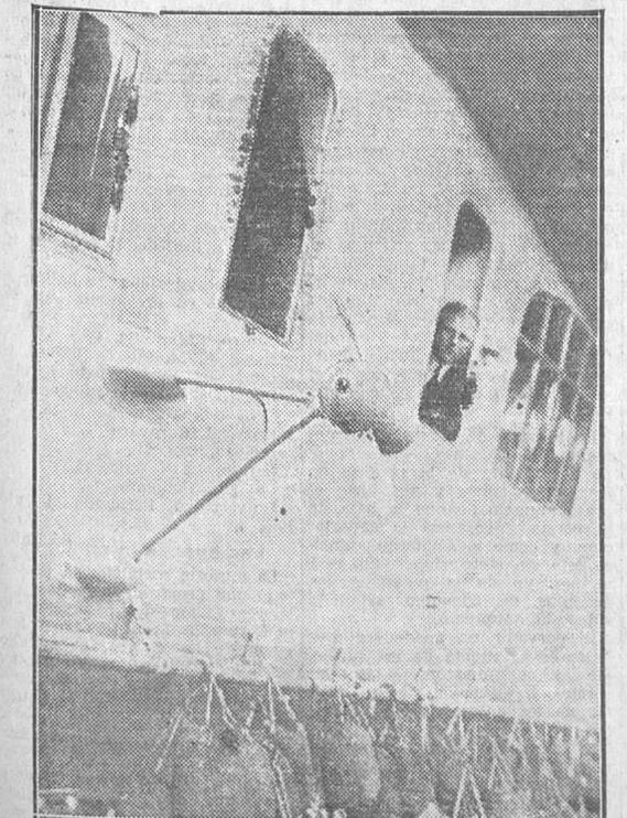
En el costado de la barquilla inmensa del gigantesco dirigible se muestra el molinete donde se arrolla la antena, que es su lazo de unión con las terrestres
