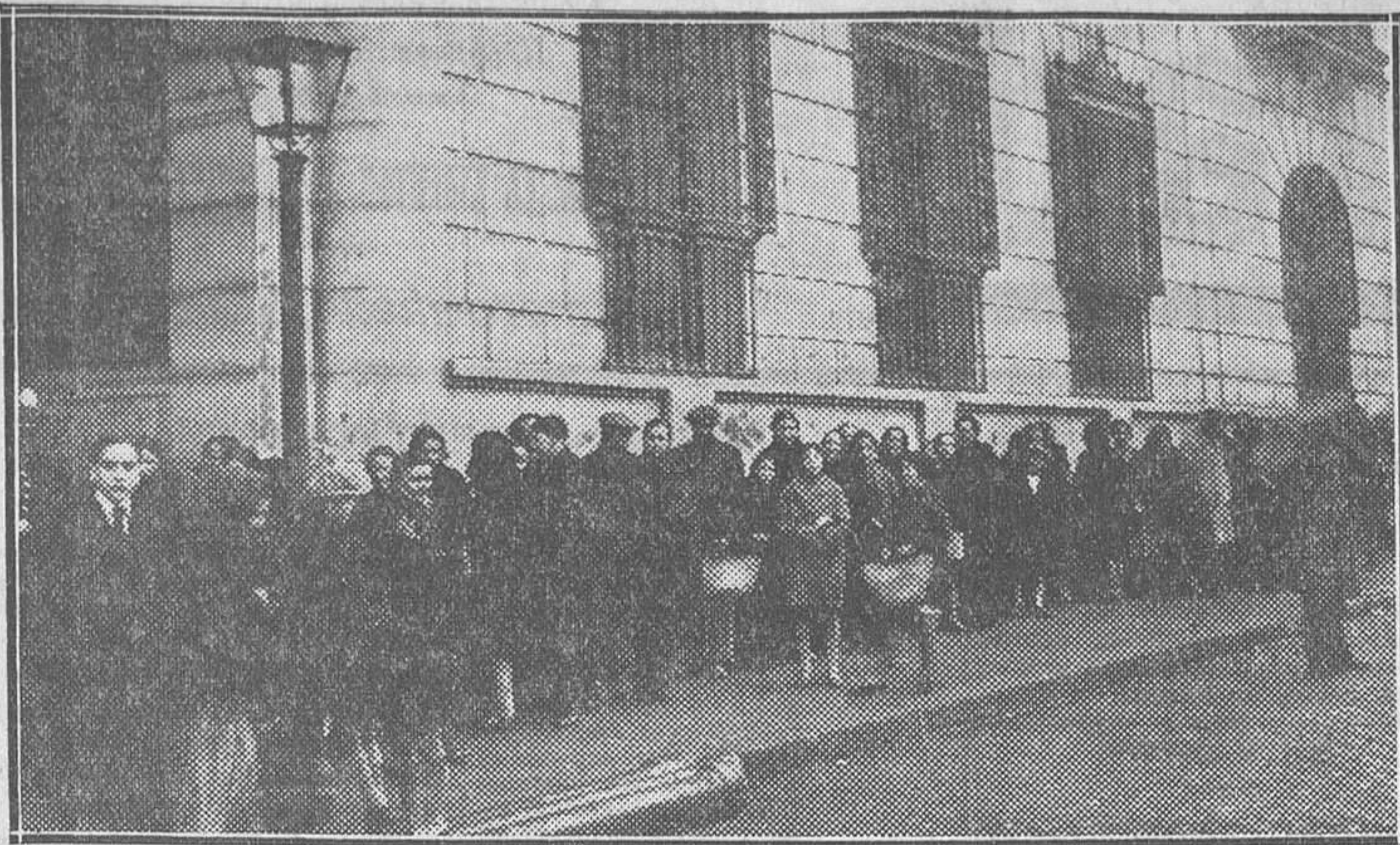
Esperando el reparto de ropas y comestibles que se hizo ayer en la Casa de socorro del distrito de la Universidad (Fot. Alfonso)
