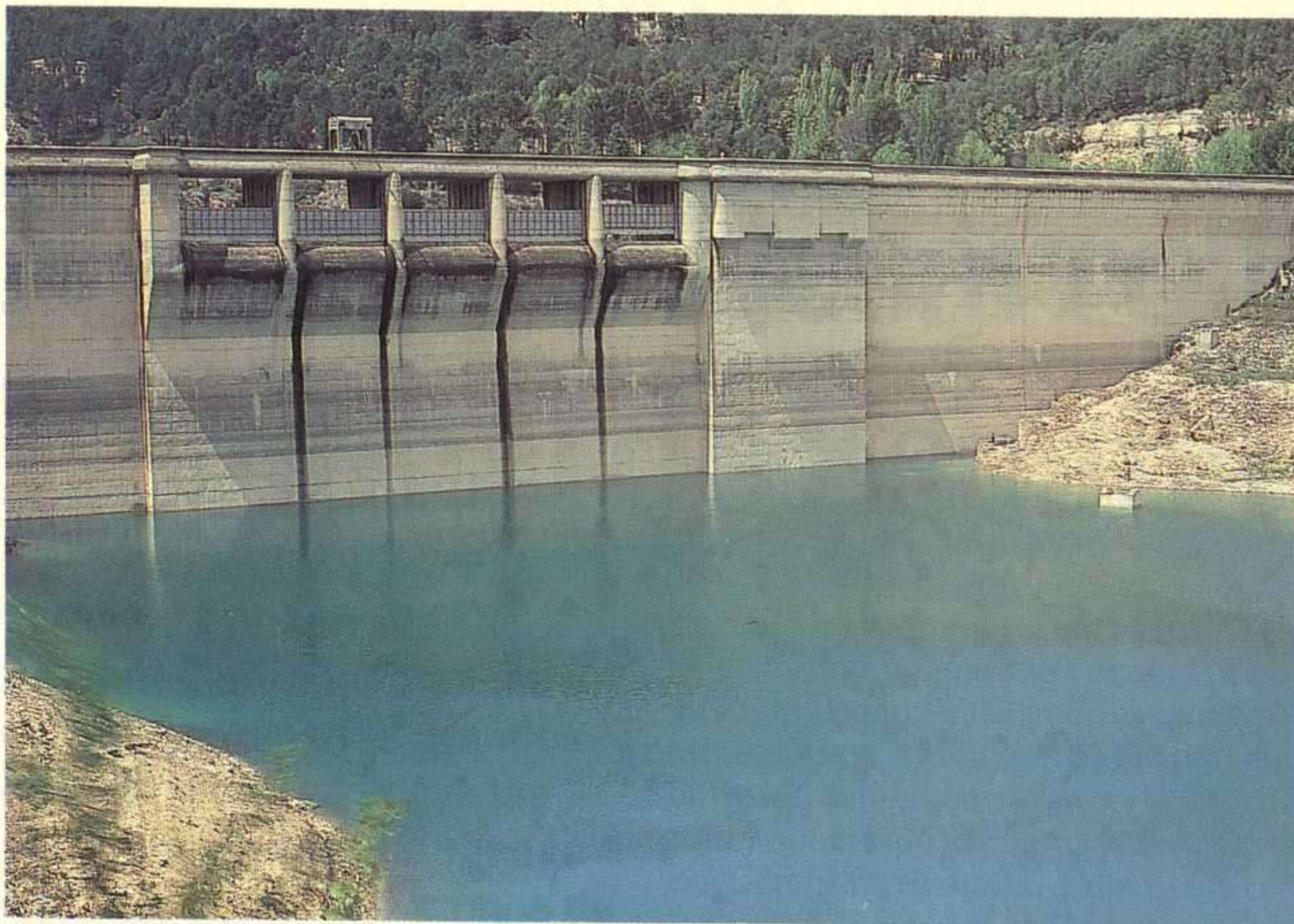
El PDR incluye la construcción de varios embalses.
