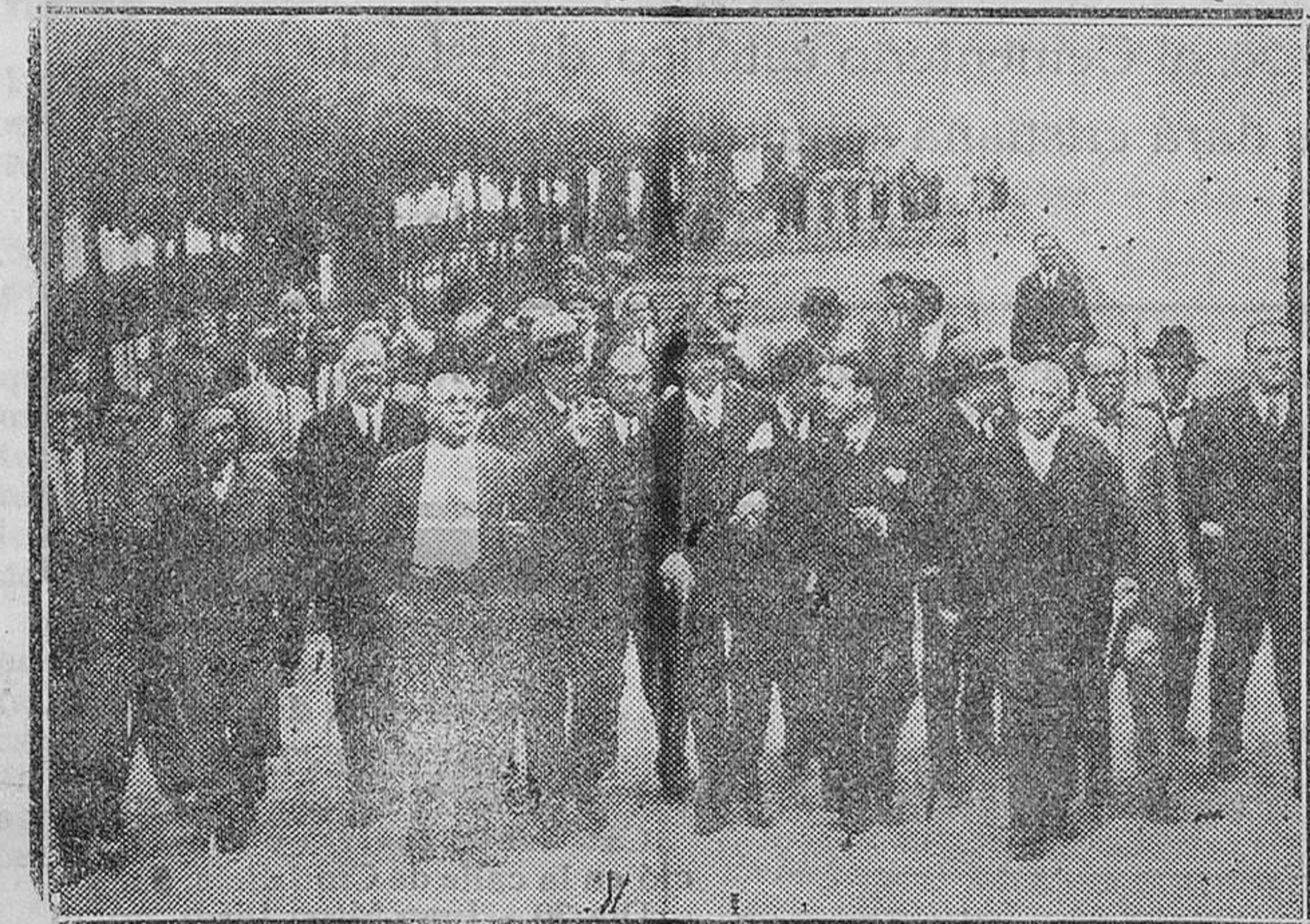
VIAJE DEL MINISTRO DE OBRAS PÚBLICAS A ZARAGOZA El señor Guerra del Río durante la visita al palacio de Compuertas del Canal Imperial acompañado por don Lorenzo Pardo
