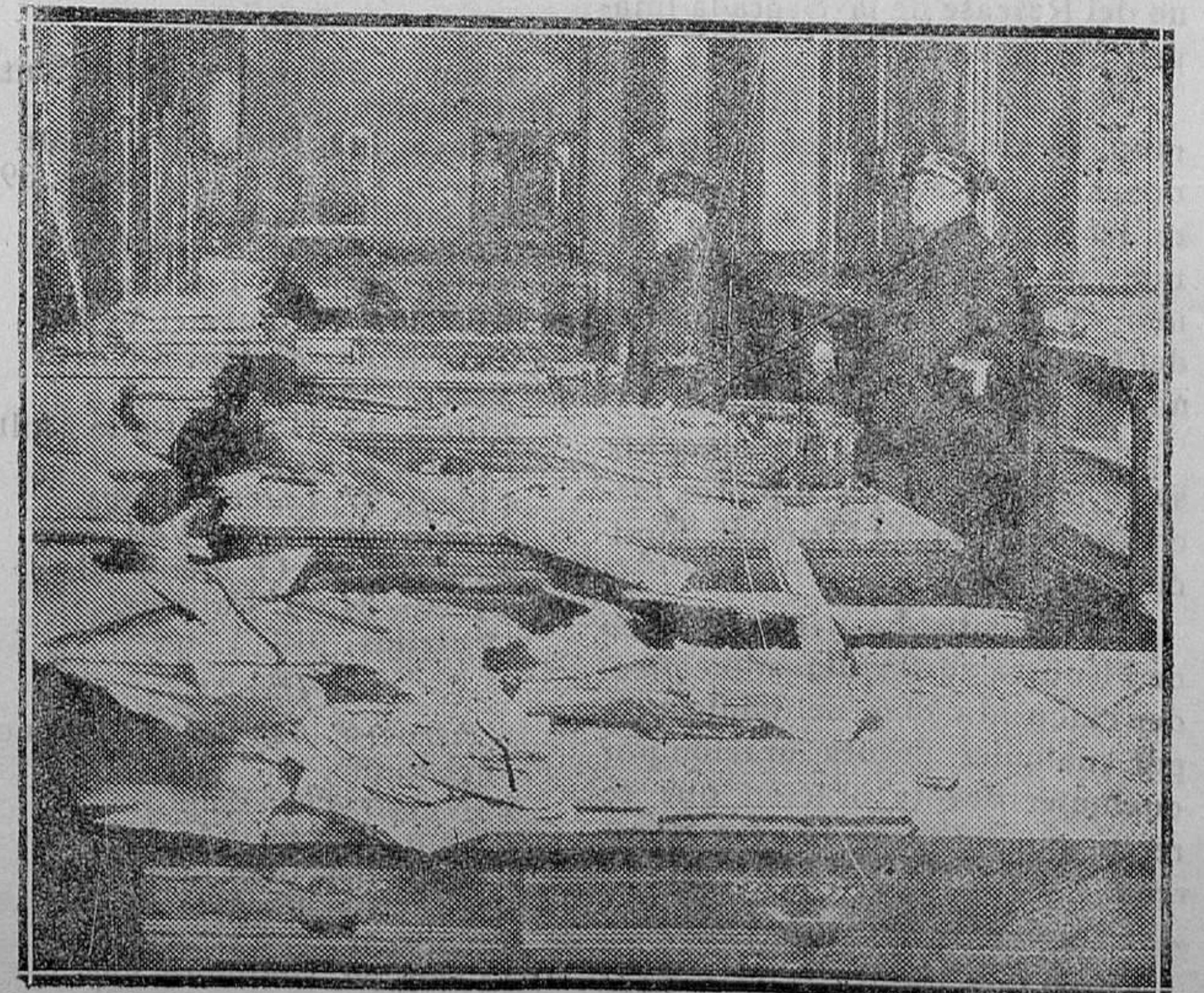
De la explosión de una bomba en el Ayuntamiento de Barcelona. — Despectos causados por la explosión en las oficinas de Intervención
