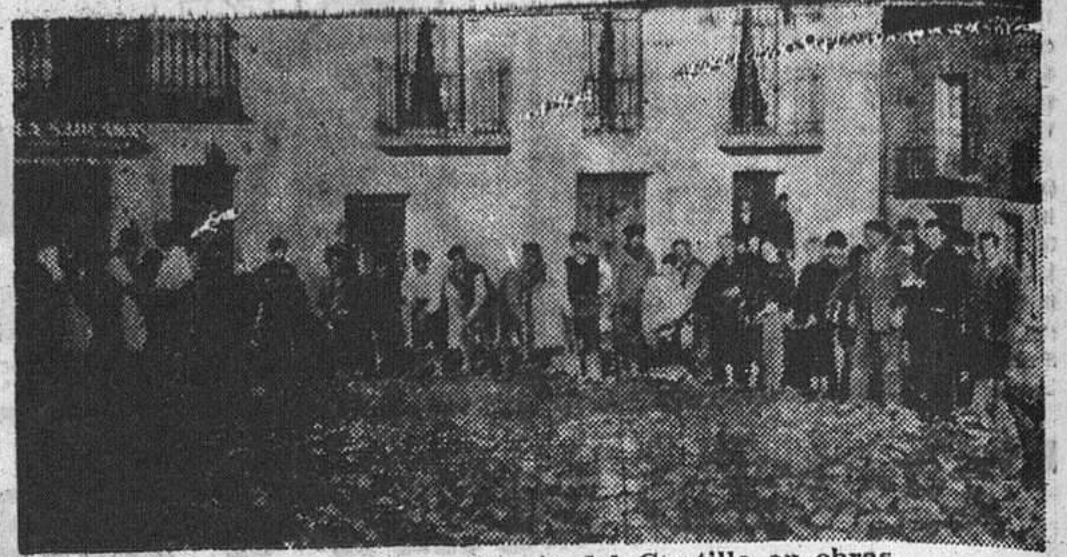
La Plaza de Santa María del Castillo en obras.
