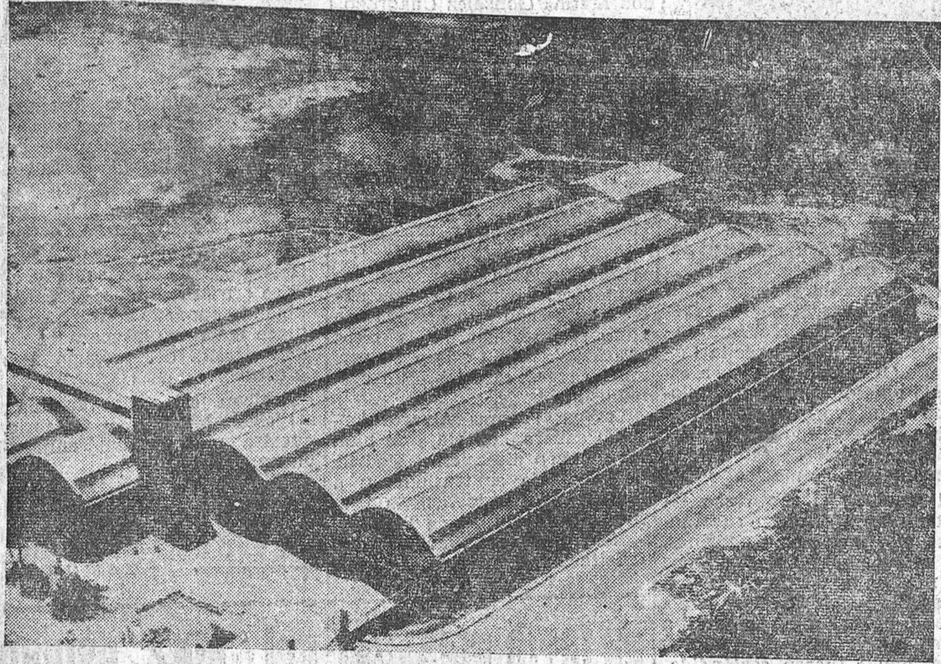
VIGO.—Vista exterior de la primera nave de PONTESA, alfares de Fuentesampayo, junto a la ría de Vigo, que fue inaugurada por el Caudillo esta mañana. Esta nueva industria de la cerámica ocupará en su desarrollo final una superficie de 100.000 metros cuadrados. La fase inaugurada hoy consta de una nave de 15.000 metros cuadrados.—(Foto Cifra Gráfica.)
