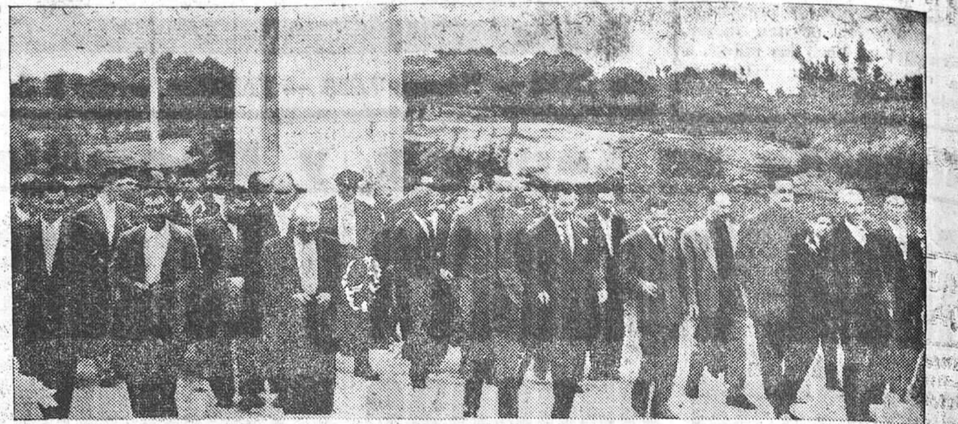
LAS AUTORIDADES JUNTO AL TRANSFORMADOR BENDECIDO EN MAMOLES.—(Foto Trabanca)
