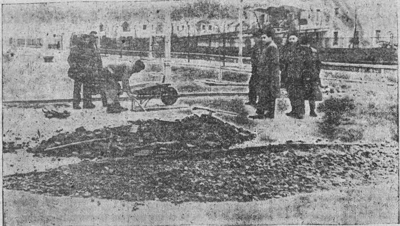
En el entronque de la Avenida de Carlos Pinilla con la carretera de Tordesillas ha fallado la nueva tubería de sesenta centímetros de diámetro que conduce el agua desde la Estación Depuradora hasta el Depósito de Cola, en el momento en que se pretendía llenar éste en el curso de las pruebas que se vienen desarrollando desde hace algún tiempo.
