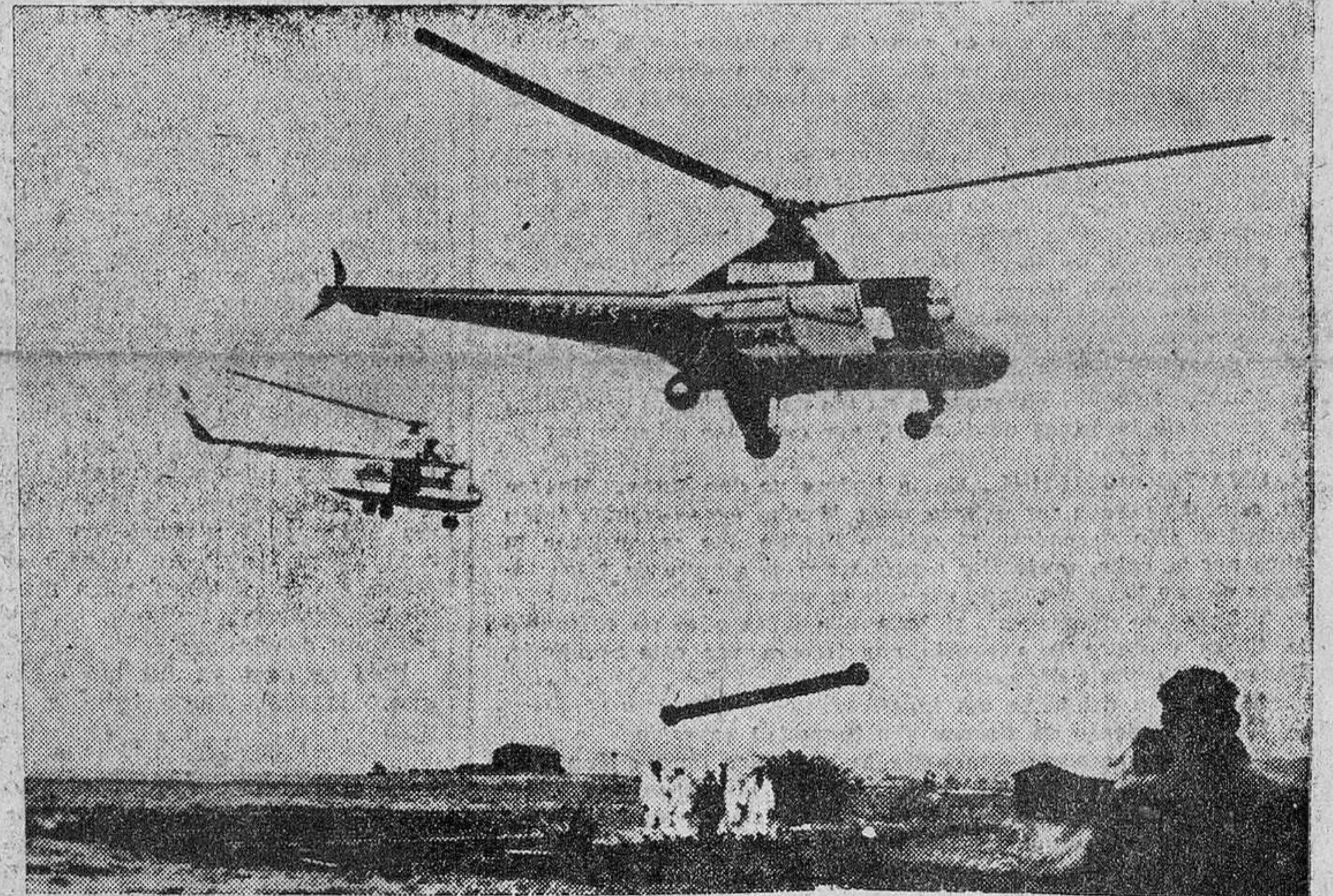
TRAWSEND (KENT). Por primera vez en Inglaterra, un helicóptero ha sido empleado para colocar una línea de tubos de la Associated Pritia nd Cement Manufacturers, que se usará para transportar mezcla líquida de cemento. En la fotografía, el helicóptero se dispone a descargar una de las secciones sobre los pantanos Cliffe. — (Foto San Antonio.)
