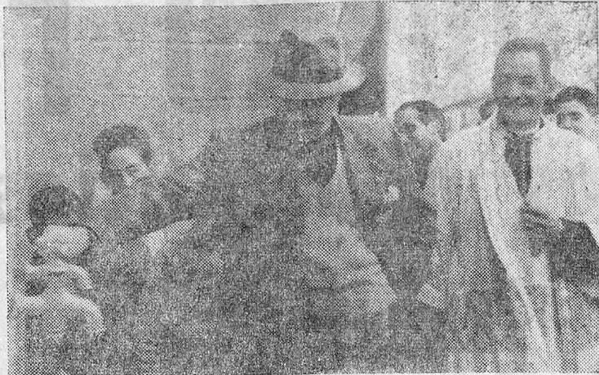
Nuevo abastecimiento de agua.
