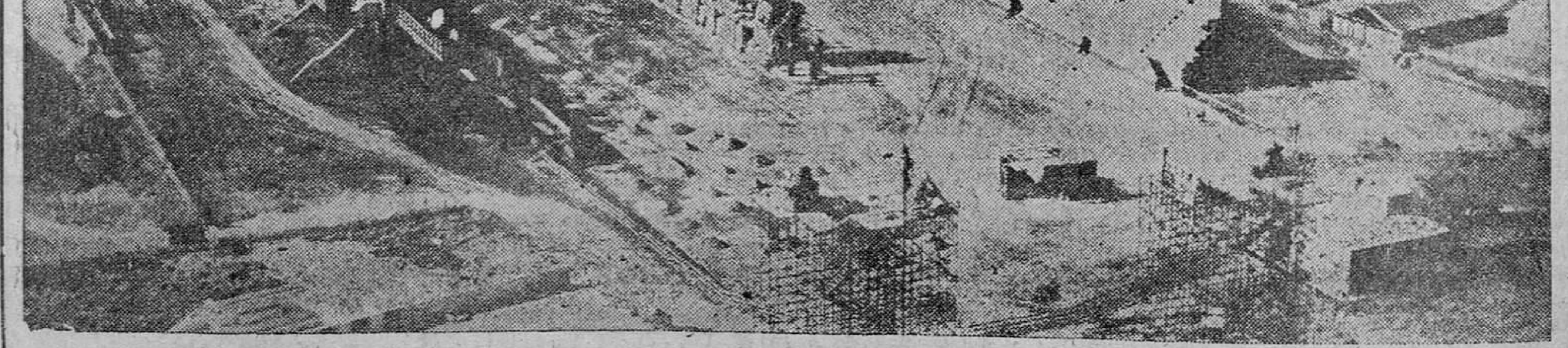
La panorámica muestra el ingente trabajo llevado a cabo para la reconstrucción del circo que servirá de escenario al rodaje de «Ben Hur». Tiene 500 metros de largo y más de 200 de ancho.
