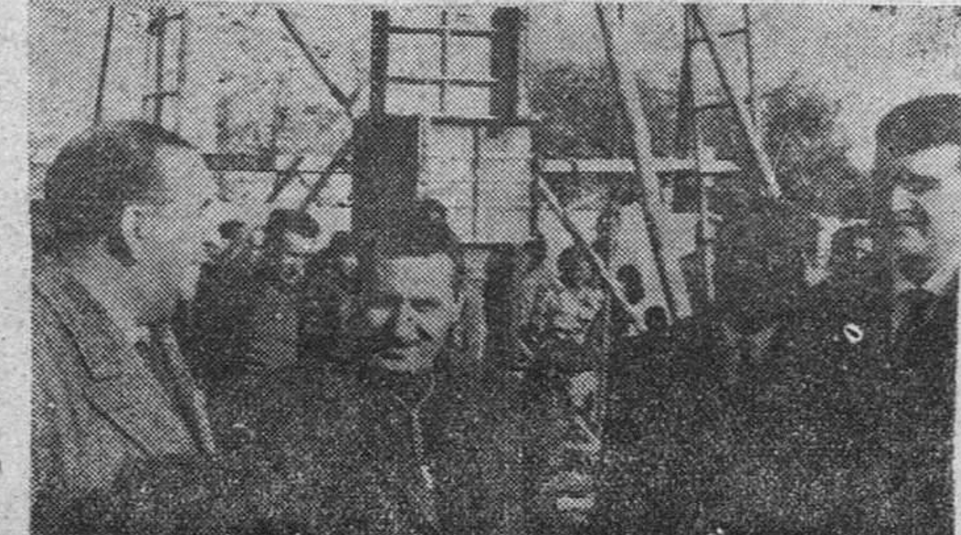
Momento de la visita a las obras de construcción de la fábrica de deshidratación de alfalfa IDETASA.—(Foto Parra, hijo.)
