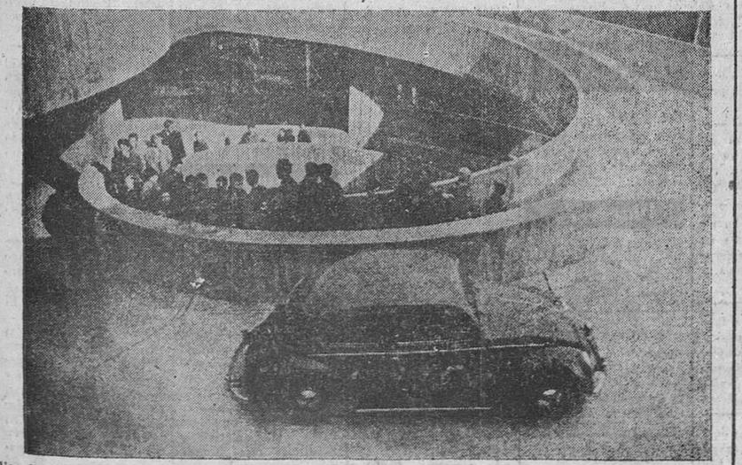
Un almacén de comercio alemán ha instalado el primer estacionamiento elevado de su país. Los coches ascienden por una pista en espiral hasta el techo del edificio, en el que se ha instalado una cochera. (Foto Keystone.)
