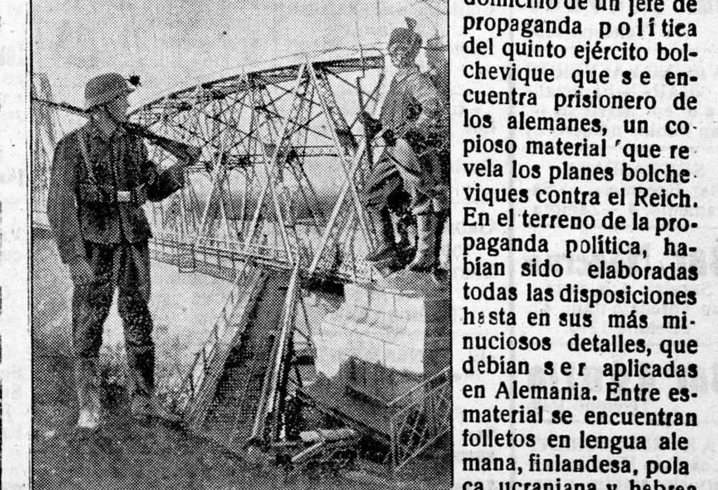
Centinela alemán de vigilancia en un puente
