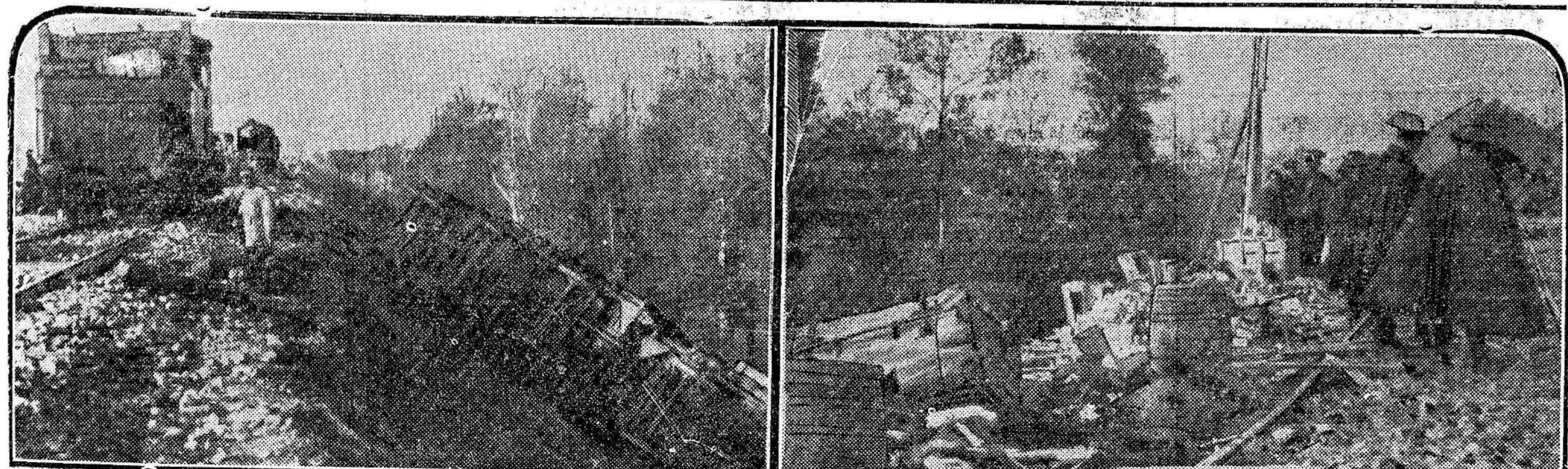
Del grave accidente ferroviario ocurrido el sábado en San Fernando de Jarama.—(De izquierda a derecha). Varios de los vagones del tren abordado que cayeron por un terrapién, y la guardia civil custodiando las mercancías, que con motivo del choque quedaron desparramadas por el suelo
