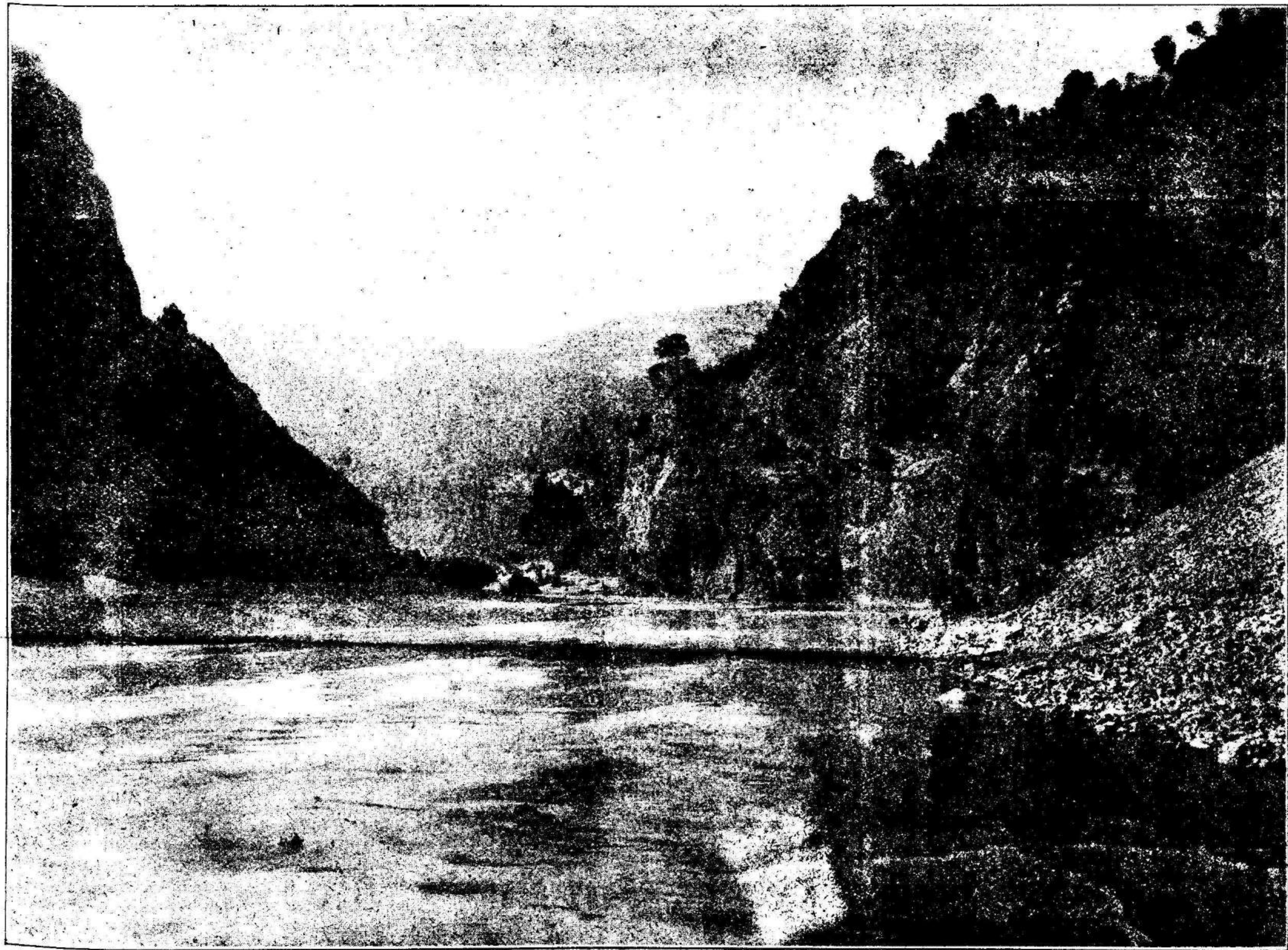
Emplazamiento de la presa del pantano de Zenajo
