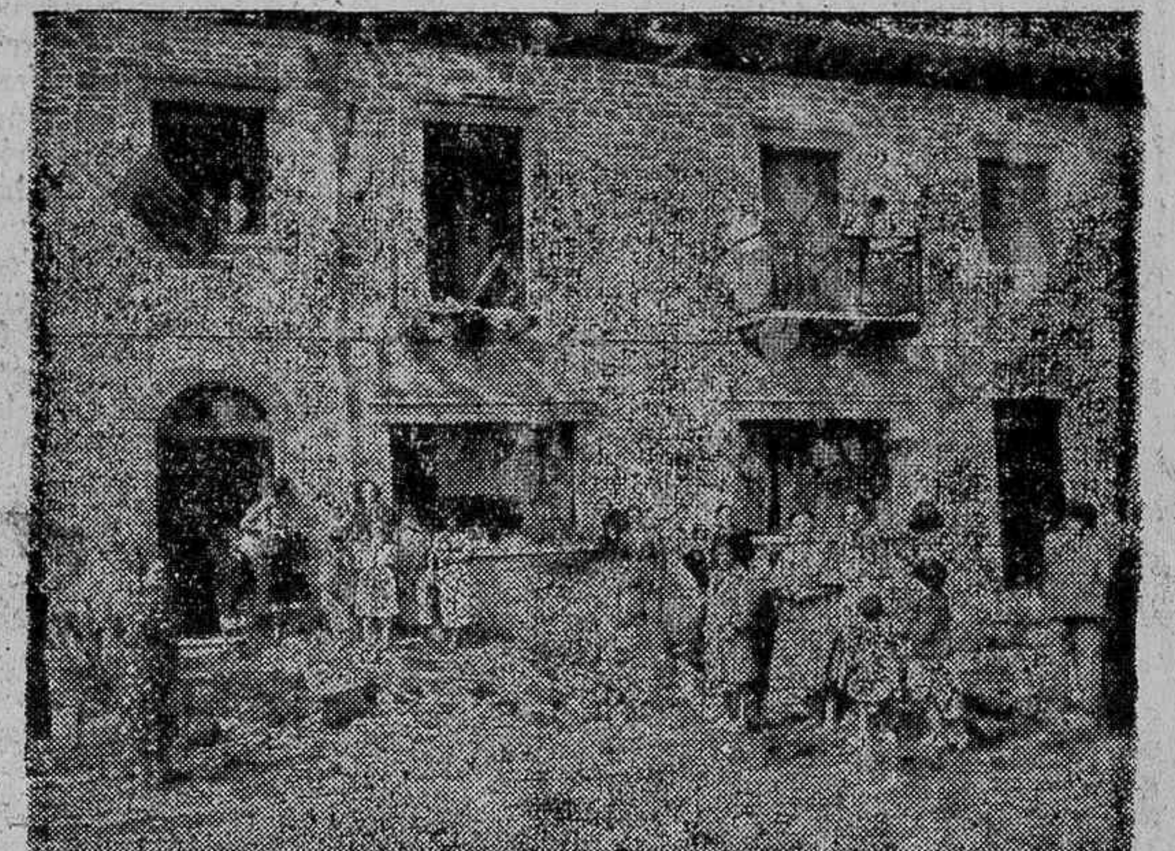
En esta casa humilde ha causado esta mañana grandes destrozos la metralla de los aviones rojos.
