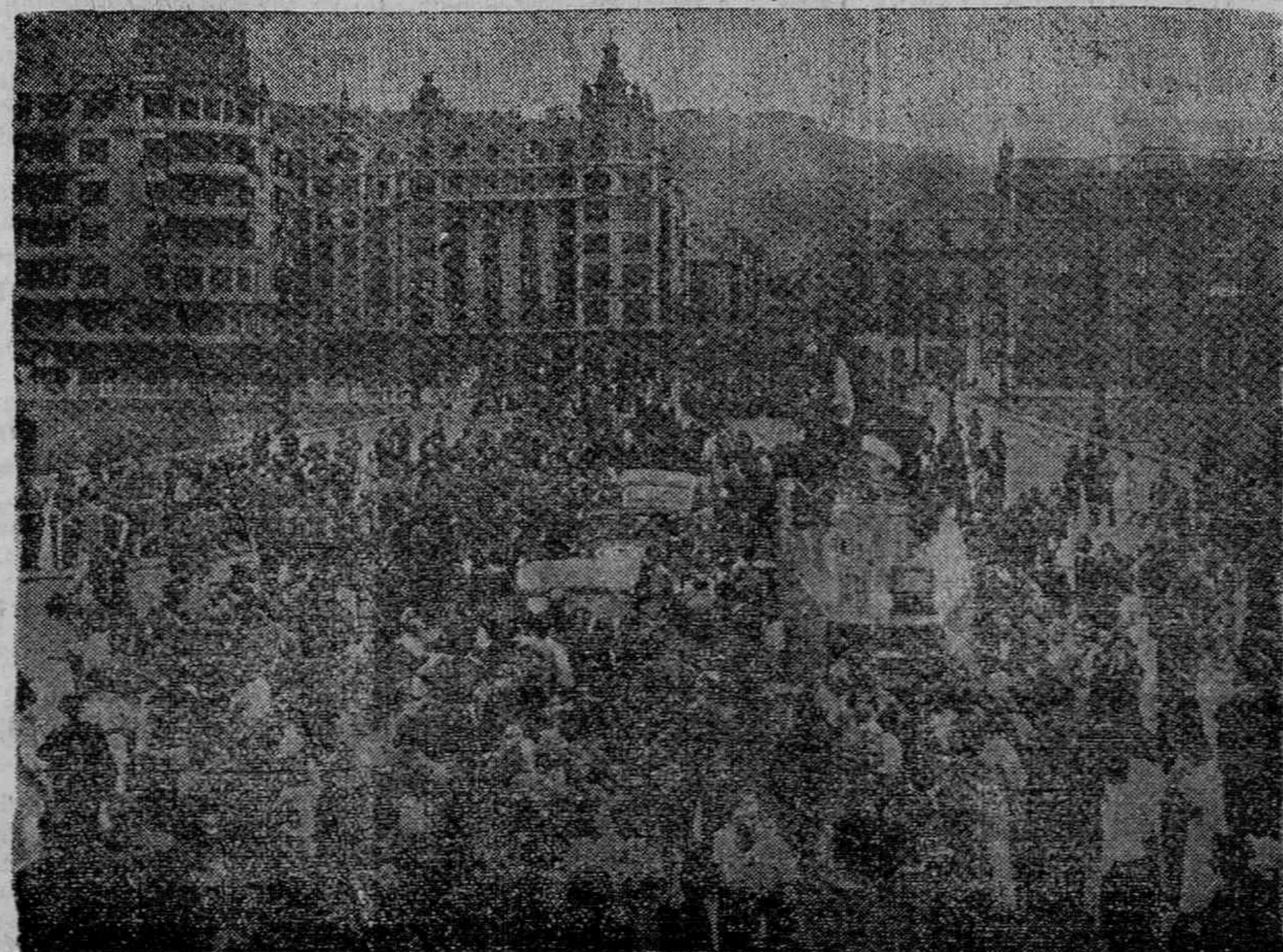
La entrada de nuestras tropas en San Sebastián, por el Puente de Santa Catalina, entre los aplausos y vítores del vecindario
