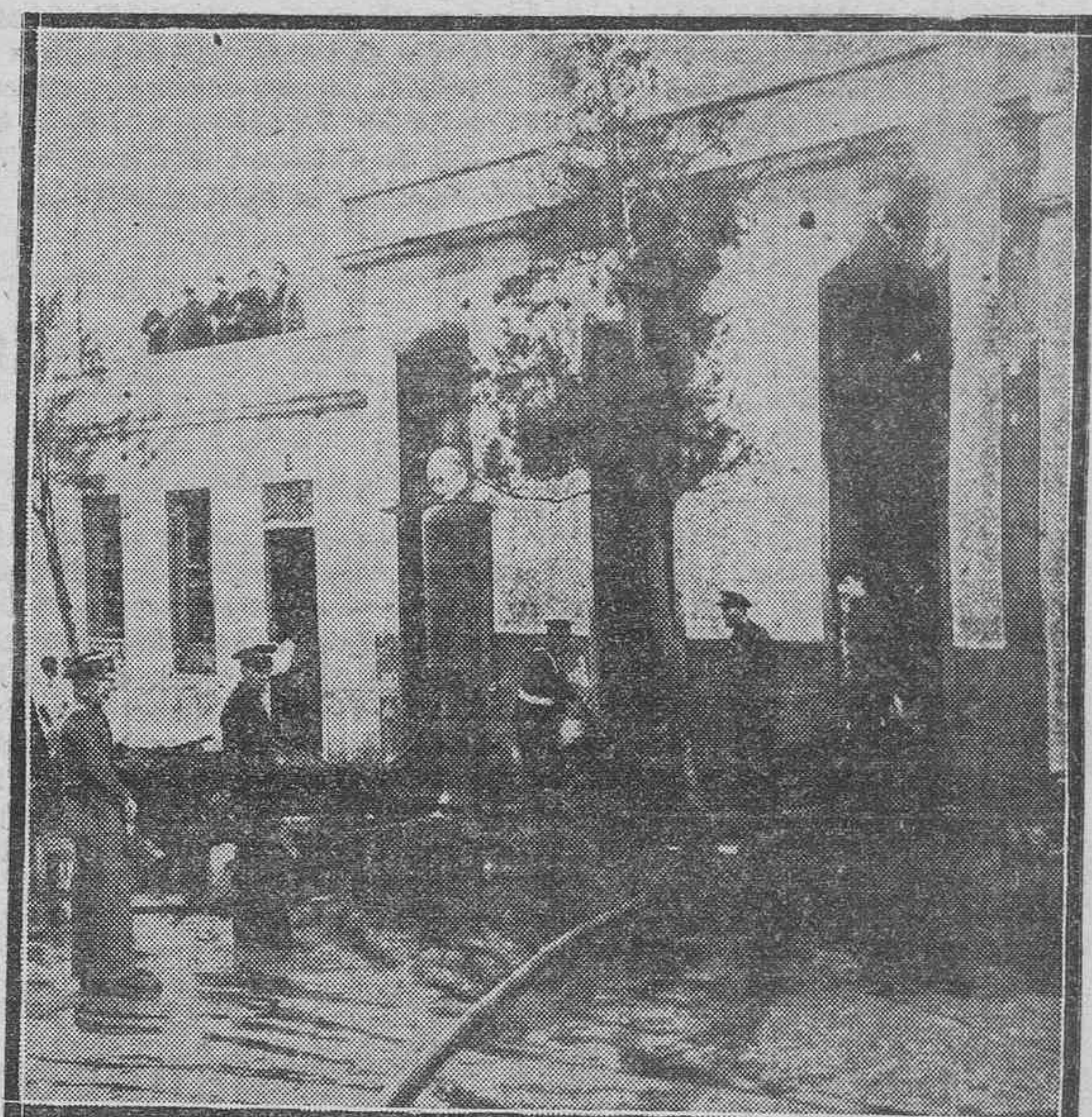
Un detalle de los trabajos de extinción del incendio producido ayer tarde en un depósito de licores de la Rambla de Benítez de Lugo.—(Foto Garriga).
