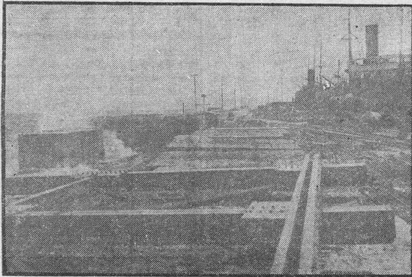
DE LAS OBRAS DEL PUERTO.—Un detalle del dique-sur donde se están efectuando los trabajos de la actual contrata.—La preparación de bloques.
