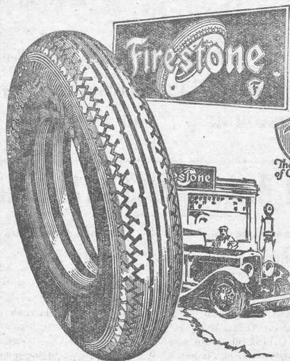
Cuando la FIRESTONE estaba ensayando el neumático balón era imprescindible diseñar una banda de rodamiento completamente diferente, de aquella que se requería para los neumáticos de alta presión.
