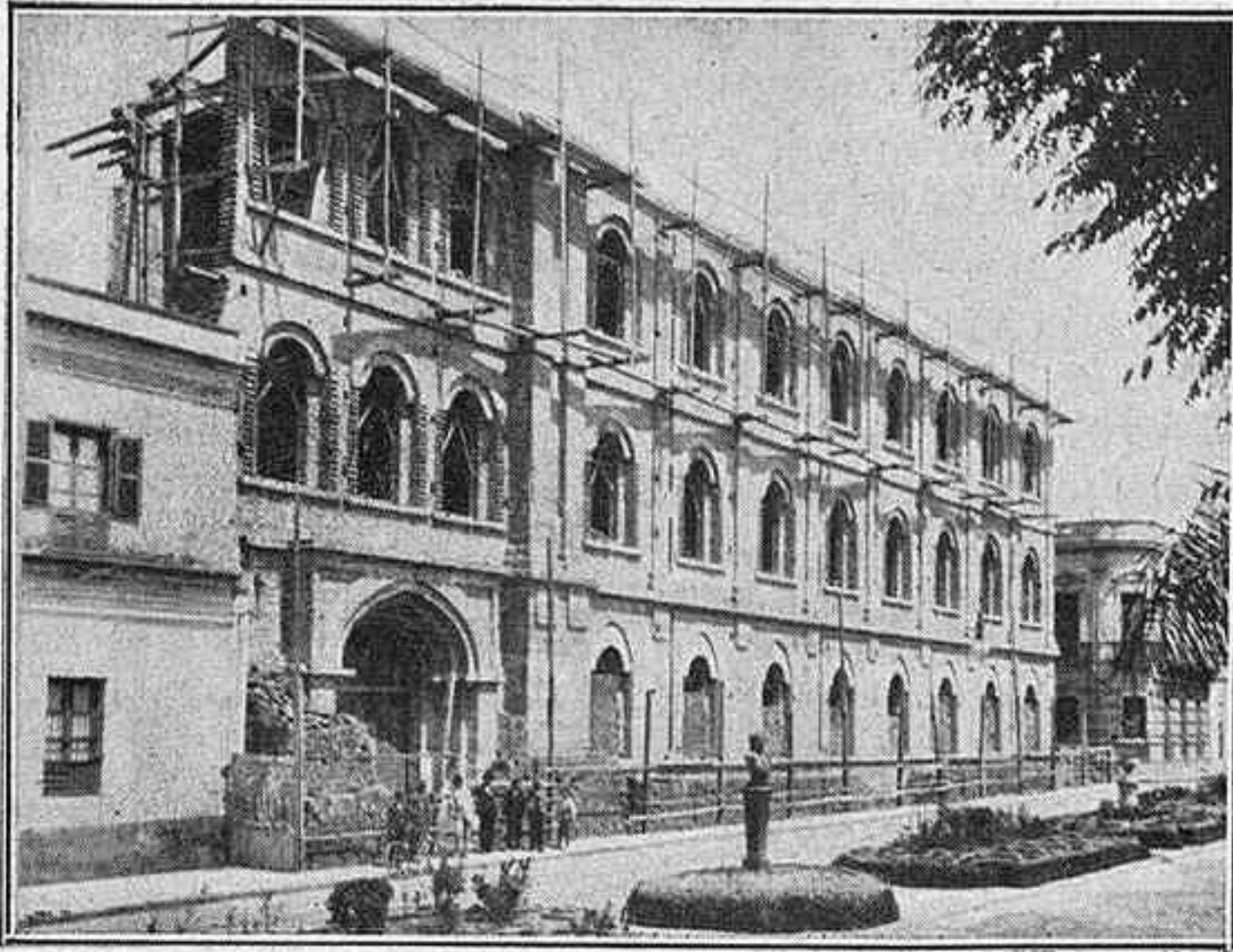
República Argentina.—Nuevo Colegio de Santa Fe en construcción.
