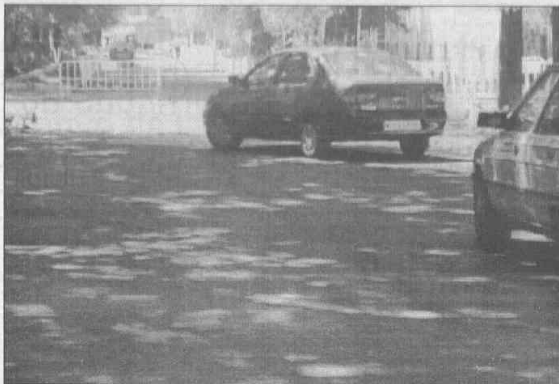
Poco a poco.- Una parte de la nueva forma de la calle Florida ya tiene firme. Las obras siguen a buen ritmo y se espera que pueda ser inaugurada antes de lo previsto aunque aún falta mucho por hacer.
