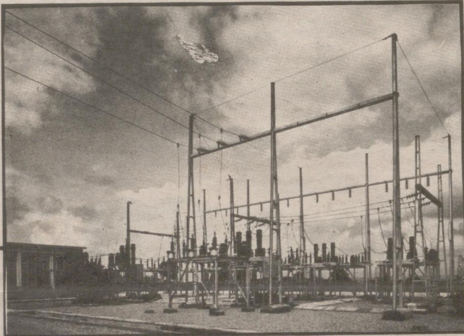
S.E.T. de Calanda. Instalación nueva con cuatro líneas a la tensión de 45 kv, transformador de 6.300 kv. A; relación 45-30/10 kv. y 7 celdas de 10 kv.
