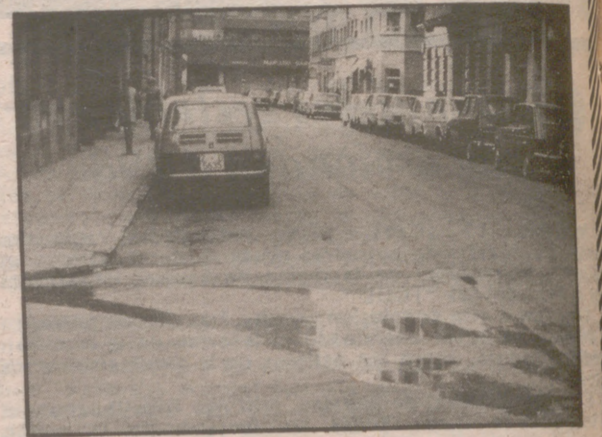
BOCAS DE RIEGO ESTROPEADAS
