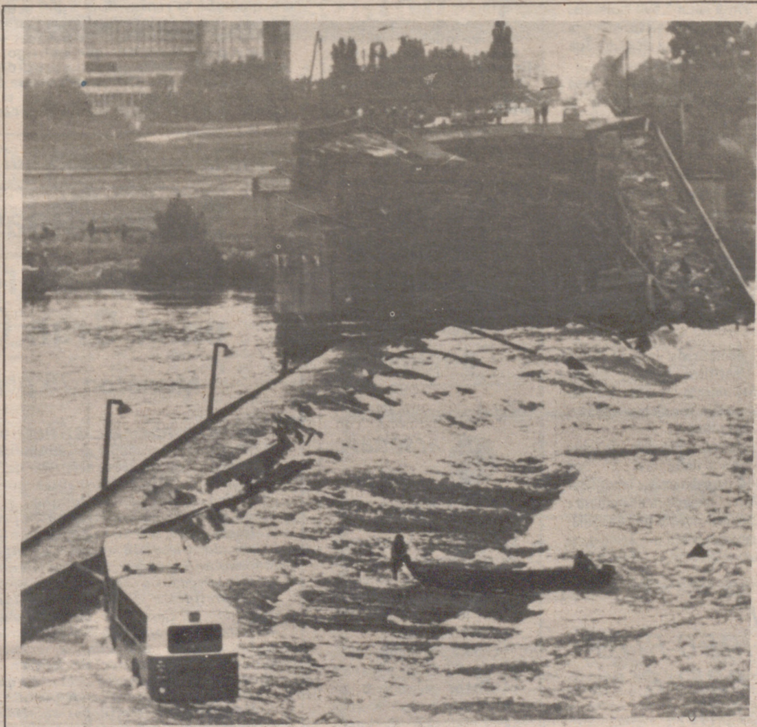
SE HUNDIO EL PUENTE
