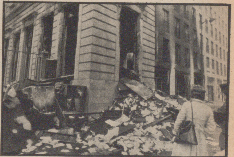
PARIS.— Un bombero y una peatón observan los daños ocasionados a un edificio local en la Avenida de Matignon, por una explosión. No hubo que lamentar víctimas, pero el fuego que siguió a la explosión destruyó la mayoría de las oficinas del edificio, de cinco pisos, no muy lejano a la Embajada de Israel. Se desconoce, por el momento, la causa de la explosión.
