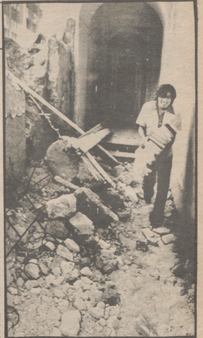
GUATEMALA. -Un joven saca de su casa en ruinas algunas de sus pertenencias, después del devastador temblor de tierra.
