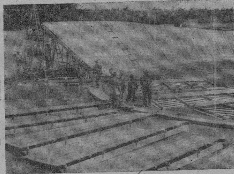
En la obra intervienen 60.000 tornillos; uno de los cuales es el eje del grupo —nos contó esto y aquello del nuevo velódromo y que nosotros —indiscretos— les contamos a ustedes
