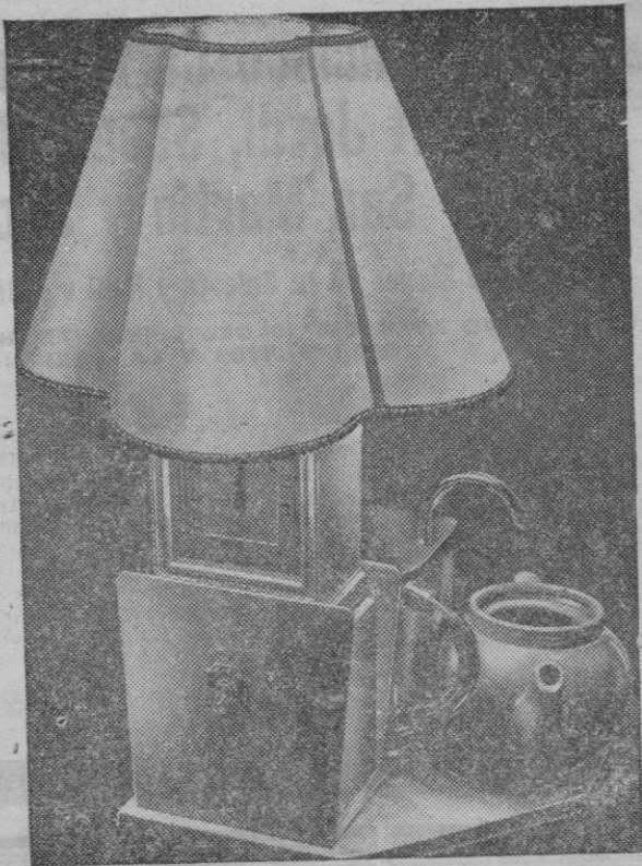
Equipo doméstico combinado de cabecera, compuesto de un despertador, un servicio de té para servir una taza a una hora determinada, y de un interruptor cómodo.
