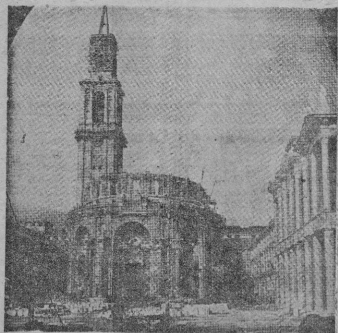
Un aspecto de las obras de la Universidad Laboral que ha sido construida en Gijón
