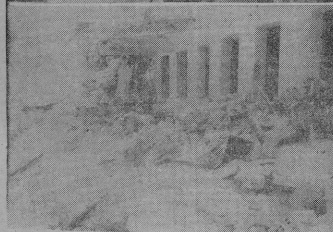
Cuatro fotos de la reciente tragedia ocurrida en Cádiz. — El General Varela, con otras autoridades, recorre la zona siniestrada. — Los talleres del Instituto Hidrográfico destruidos por la explosión. — Una víctima de la catástrofe después de la primera cura. — Pabellón del Instituto Hidrográfico, convertido en montones de ruinas.
