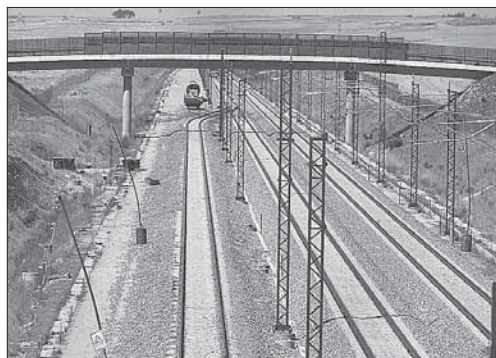
Aspecto de uno de los tramos del AVE en la provincia. / JUAN MARTÍN
