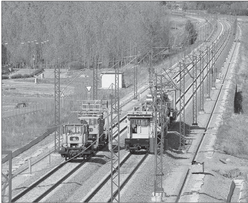
Imagen de la línea férrea del AVE a su paso por la provincia de Segovia. / F. PEÑALOSA
