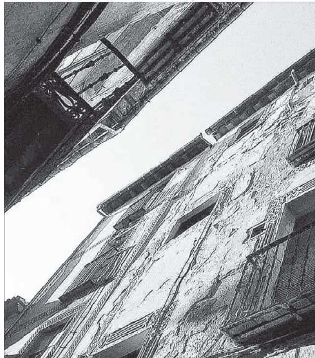
Los vecinos podrán acceder a subvenciones para reparar las fachadas y cubiertas de los inmuebles
