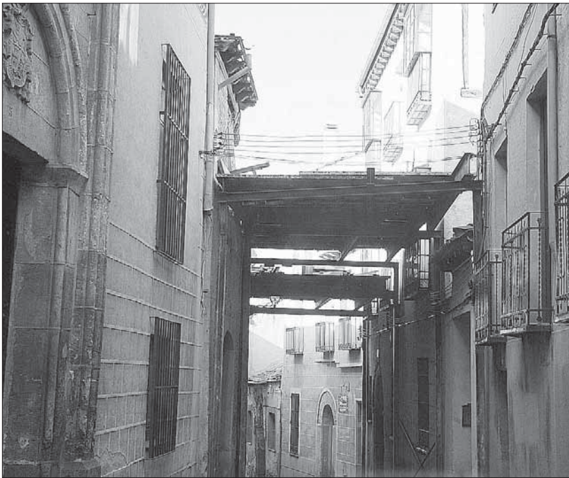
El Ayuntamiento contempla sustituir el actual andamio por otro que permita garantizar la estabilidad de la fachada/PEÑALOSA
